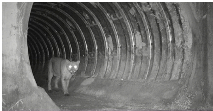
Figura 8. Passagem de fauna subterrânea na Rodovia Zeferino Vaz, no trecho conhecido como “Tapetão”, na altura do km 117, em Campinas, executada pela concessionária Rota das Bandeiras em 2022. (Foto: Eixo-SP/Divulgação).
