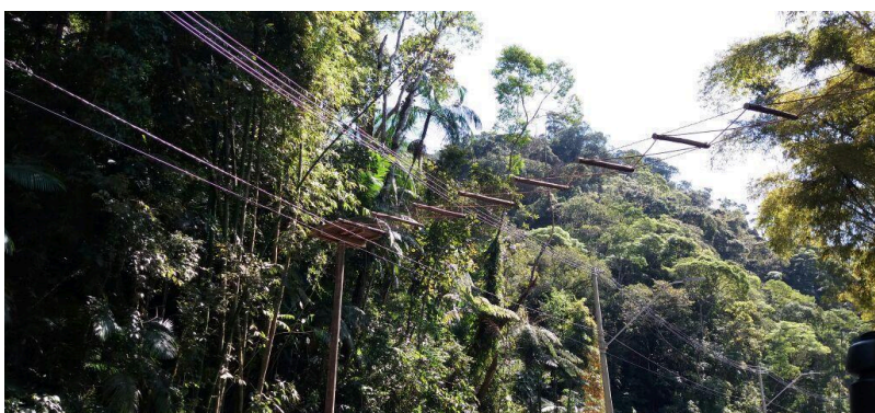
Figura 4. Passagem de fauna aérea em corda cruzando o trecho da Rodovia Tamoios, no km 65+610, no trecho de planalto de Caraguatatuba, inaugurada no dia 09 de março de 2023, contendo 62 metros de comprimento. Foi feita com cabos de aço, madeiras suspensas e cordas. Fonte: Tamoios notícias
