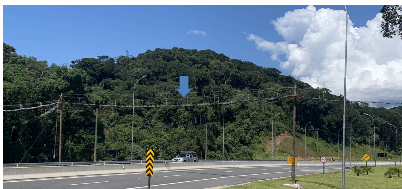
Figura 4. Passagem de fauna aérea em corda cruzando o trecho da Rodovia Tamoios, no km 65+610, no trecho de planalto de Caraguatatuba, inaugurada no dia 09 de março de 2023, contendo 62 metros de comprimento. Foi feita com cabos de aço, madeiras suspensas e cordas. Fonte: Tamoios notícias
