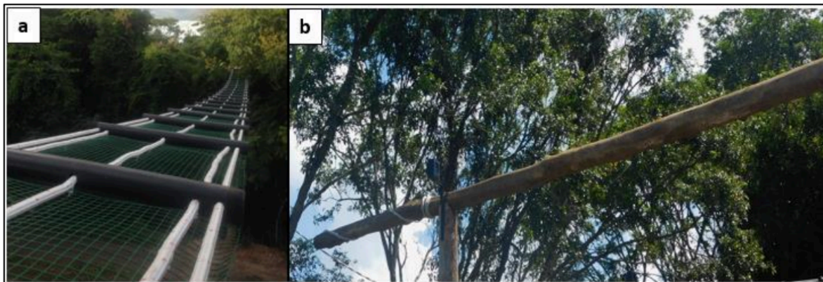
Figura 12. Foto de dois modelos de passagem de fauna do tipo “pontes de dossel” retirada do trabalho de Garcia et al (2022), feito para conservação do animal mico-leão-preto, em Guareí, SP. (a) ponte de corda, (b): ponte de madeira, feita com tronco de eucalipto. (Foto: Francini Garcia)
