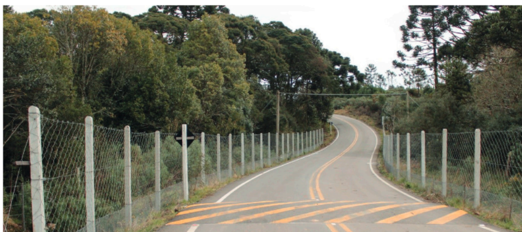
Figura 20. Cercas instaladas para evitar colisões dos animais com os carros na estrada, com a presença da lombada, que força a diminuição da velocidade dos veículos. Fonte (Gonçalves, 2023)
