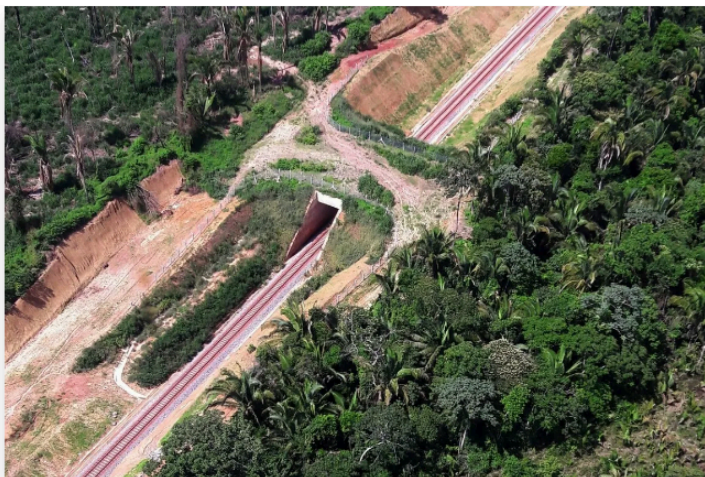
Figura 13. Primeiro viaduto com travessia para fauna no Brasil foi instalado no Pará, em 2017, no Ramal Ferroviário Sudeste do Pará, num trecho da rodovia que corta a Floresta Nacional de Carajás. Crédito: Ibama
