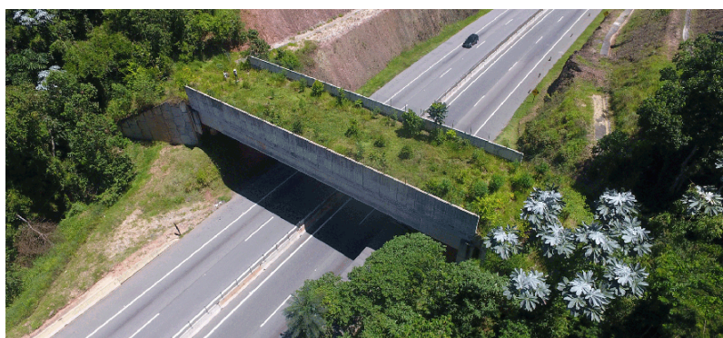
Figura 15. Passagem aérea vegetada de fauna em concreto, com cercas para guiamento dos animais, na Rodovia Tamoios, no município de Paraibuna, na região do Parque da Serra do Mar, 2021. (Foto: Dersa/Sp)
