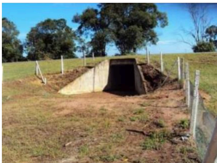
Figura 10. Passagem de fauna do tipo caixa seca com cerca condutora, na rodovia SP-225, em Brotas, Brasil. (Foto: Fernanda Delborgo Abra)
