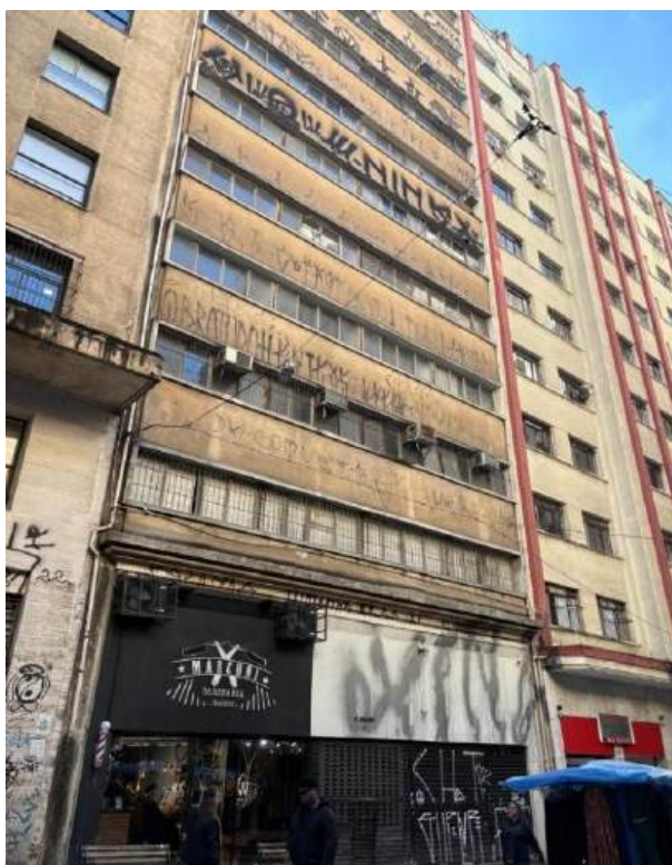
Figura 12 - Edifício não utilizado e lacrado na Rua Marconi próximo ao Theatro Municipal (Distrito República)
