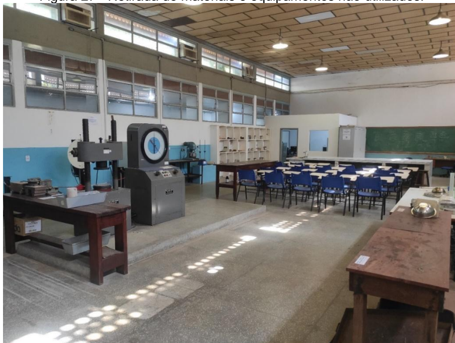
Figura 27 - Retirada de materiais e equipamentos não utilizados.
