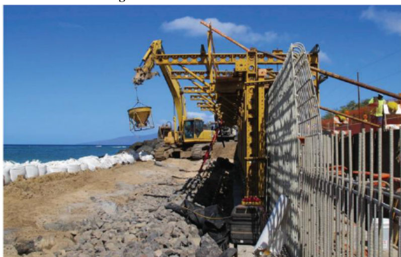
Figura 6 - Beira Mar com barra de GFRP.
