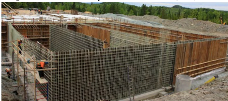
Figura 7 - Formas e barras das paredes do reservatório de Quebec, Canadá.
