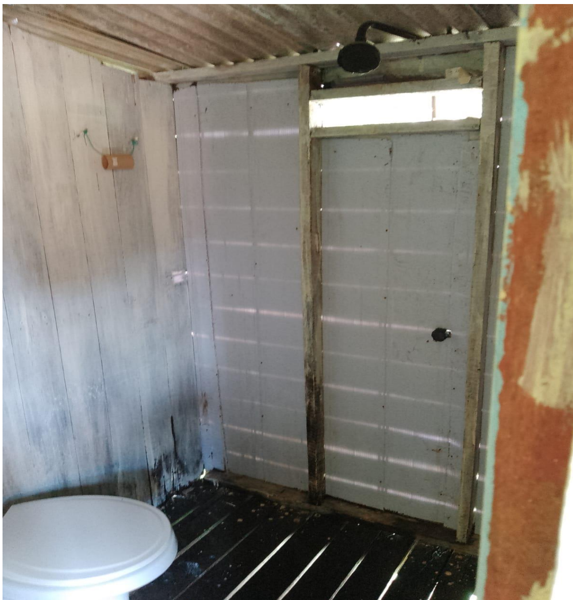
Imagem 15 – Banheiro de alojamento
