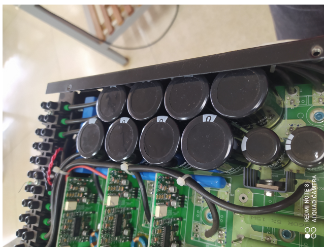
Figura 10: Banco de capacitor.
