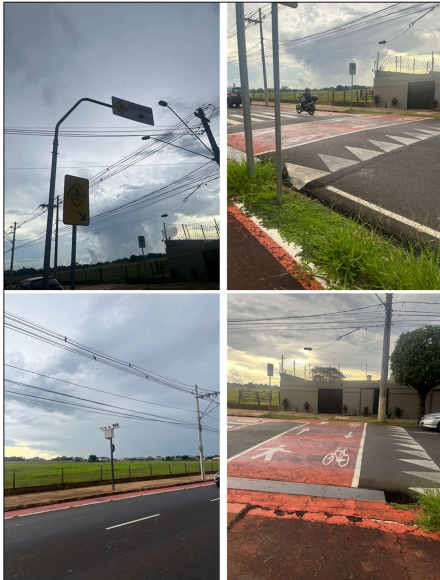
Figura 13 – Medidas de traffic calming adotadas no entorno do ponto crítico de acidentalidade viária.
