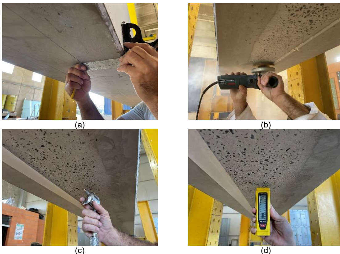
Figura 70 – Preparação do substrato do elemento a ser reforçado
