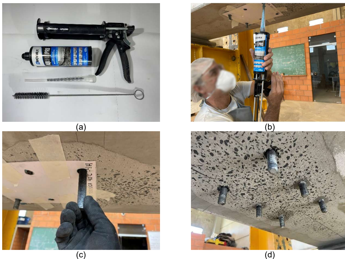
Figura 78 – Aplicação dos chumbadores químicos
