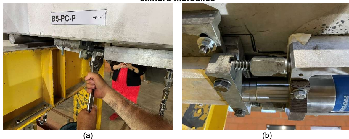
Figura 138 – Travamento dos dispositivos da ancoragem ativa para remoção do cilindro hidráulico
