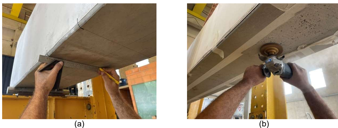
Figura 75 – Preparação do substrato do elemento a ser reforçado do reforço protendido
