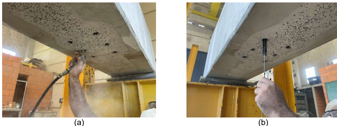
Figura 77 – Limpeza dos furos dos chumbadores
