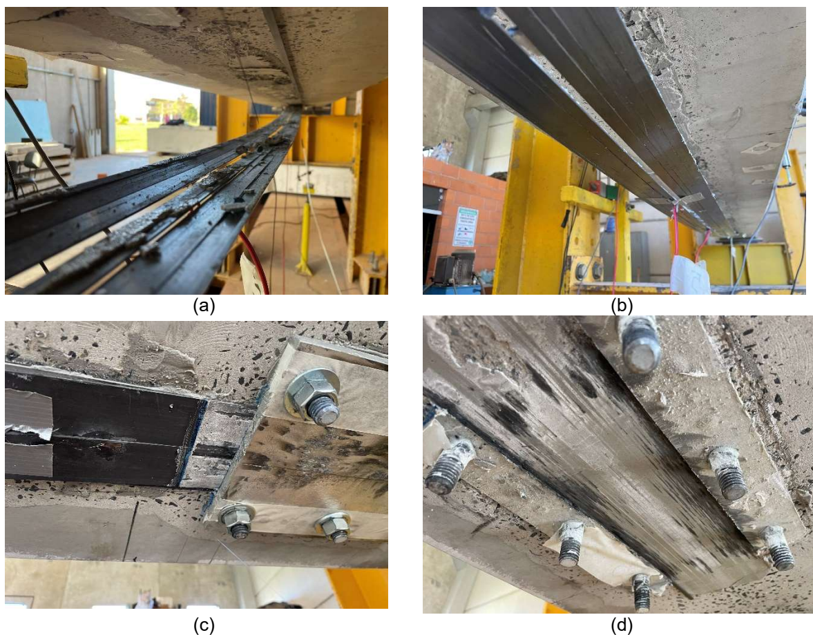
Figura 127 – Modo de modo de ruptura da viga B4-NPC-P
