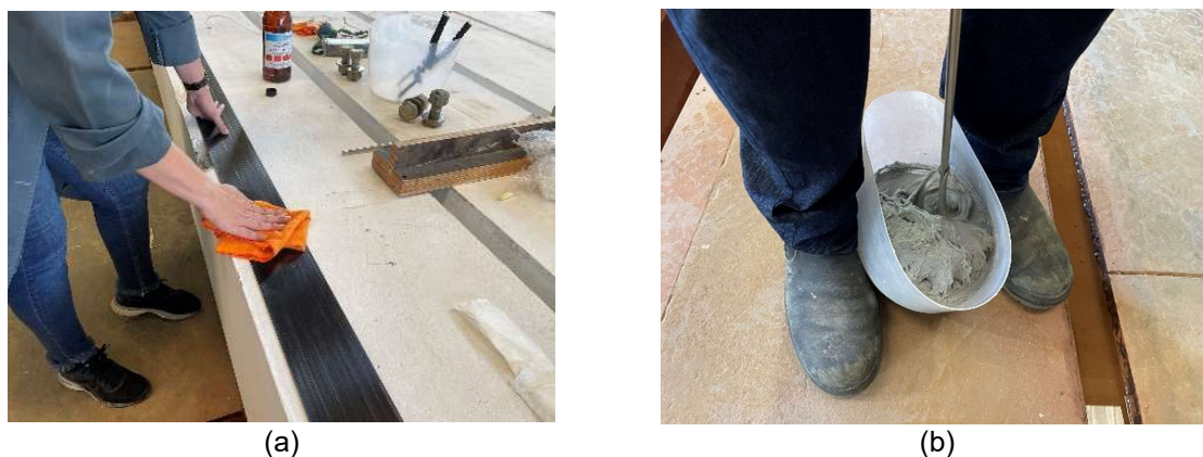
Figura 71 – Preparação dos materiais a serem aplicados do reforço passivo
