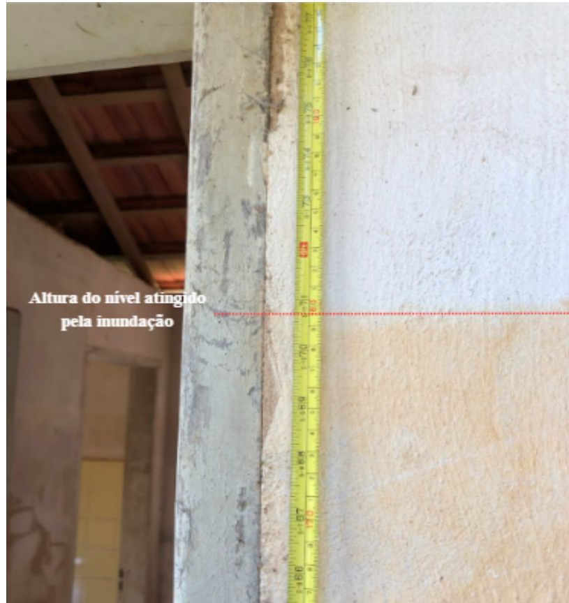
Figura 14: Exemplo de marcação dos níveis das inundações atingidos nas construções.
