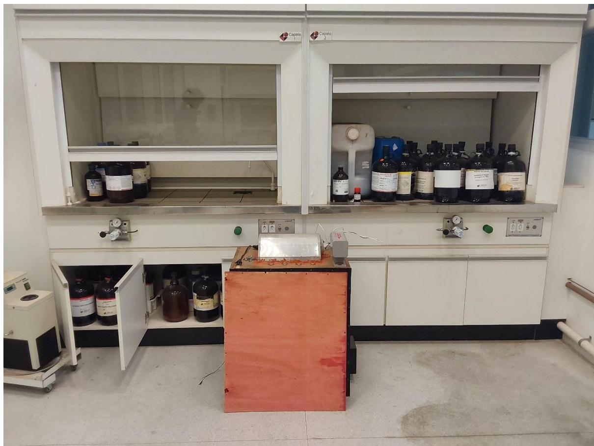
Figura 14: Capelas com problema de exaustão e sendo utilizada como armazenamento de resíduos.
