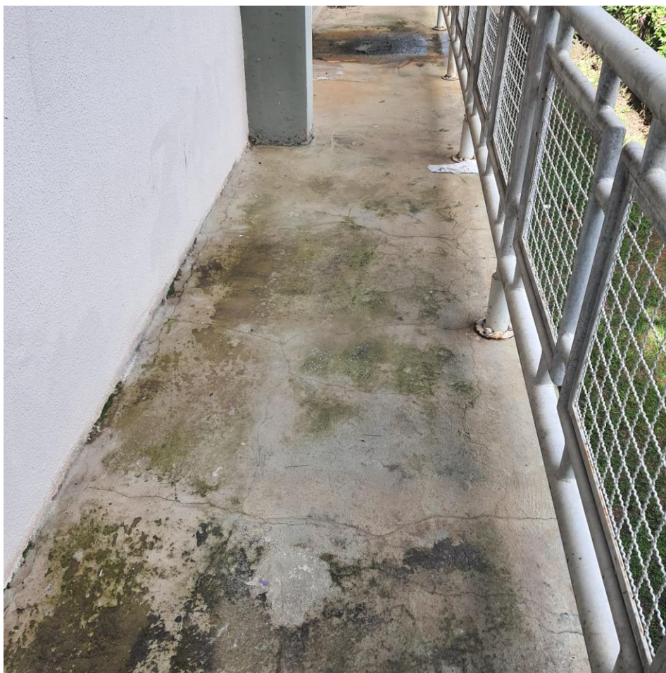
Figura 17: Local após a remoção dos resíduos
