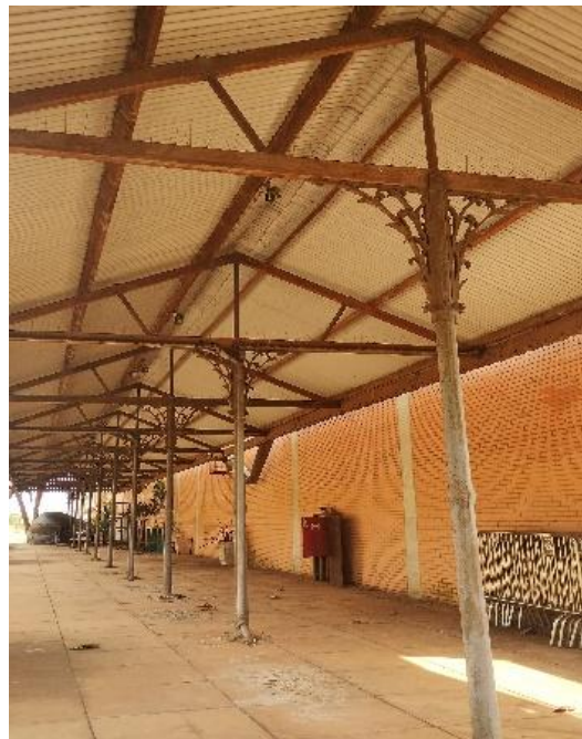
Figura 3: Arquitetura Estação Araras
