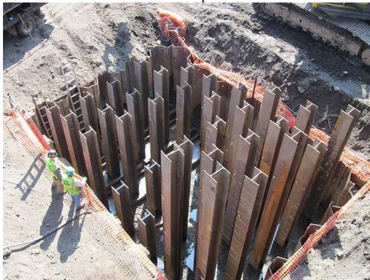
Figura 1.4 – Estacas metálicas com comprimentos de embutimento distintos
