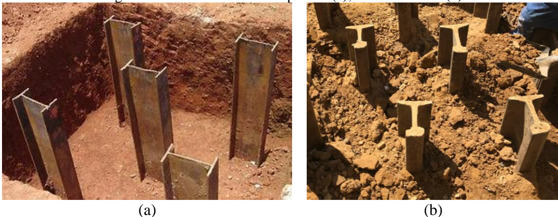
Figura 1.2 - Estacas metálicas: perfil I (a); trilhos de trem (b)
