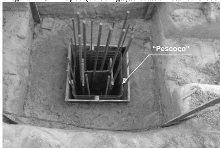
Figura 2.15 - Proposição de ligação estaca metálica-bloco
