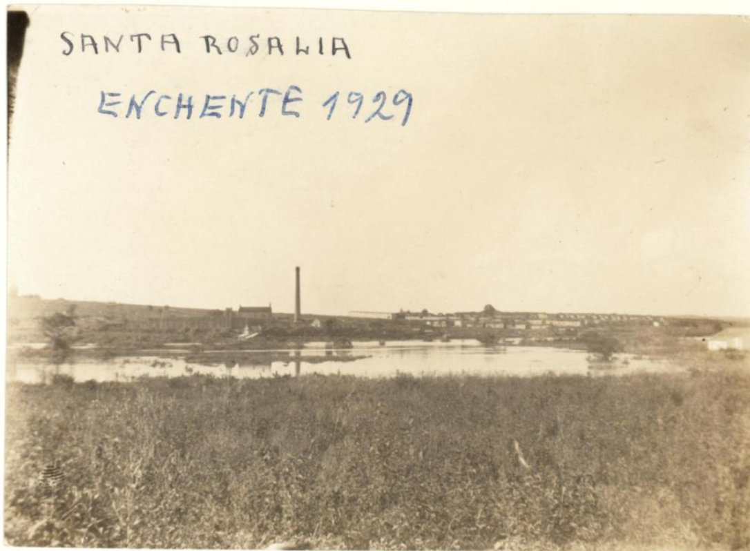
FIGURA 6 – Vista parcial de Sorocaba na Enchente de 1929 - Santa Rosália
