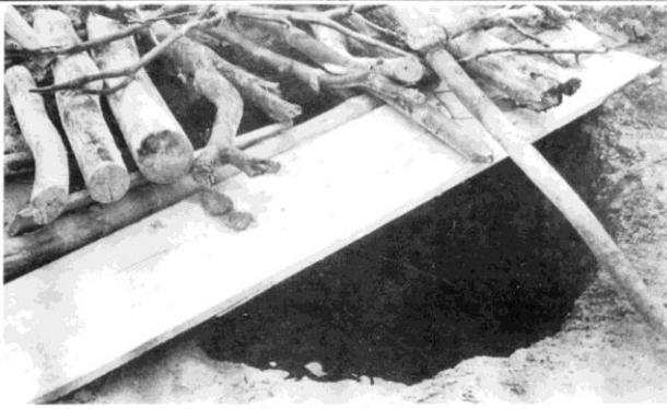
Nas fossas, um grande problema. É só cavar quase dois metros para a água aparecer.
