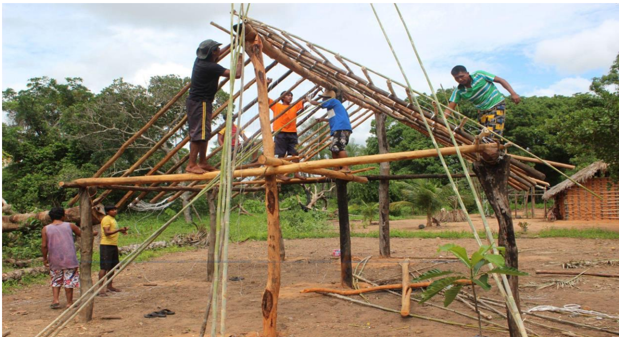
Figura 15 Mutirão de construção da casa. Foto: Felipe Kometani, 2012
