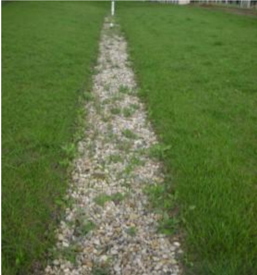
Figura 2.5 Trincheira de infiltração no campus da UFSCar
