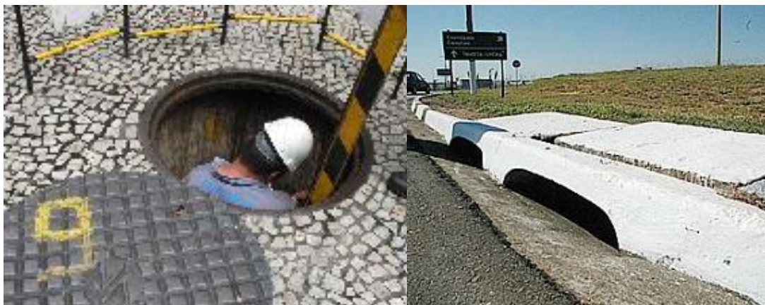
Figura 2.1 Boca-de-Lobo e Poço de Visita
