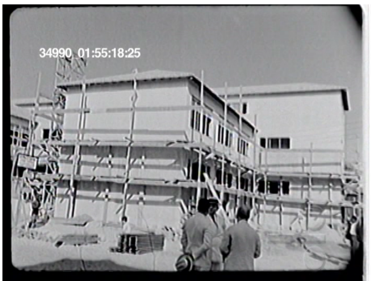
Figura 7 – Construção em andamento da Casa do Pequeno Jornaleiro. Fonte: Cine Jornal Brasileiro , v.01, n.065 (1939). Disponível em: Cinemateca Brasileira.
