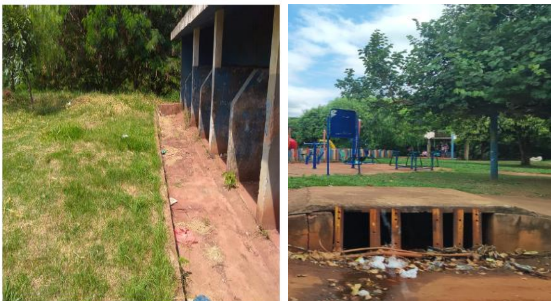
Figura 23. Estrutura de lavanderia pública instalada em Itaí – SP
