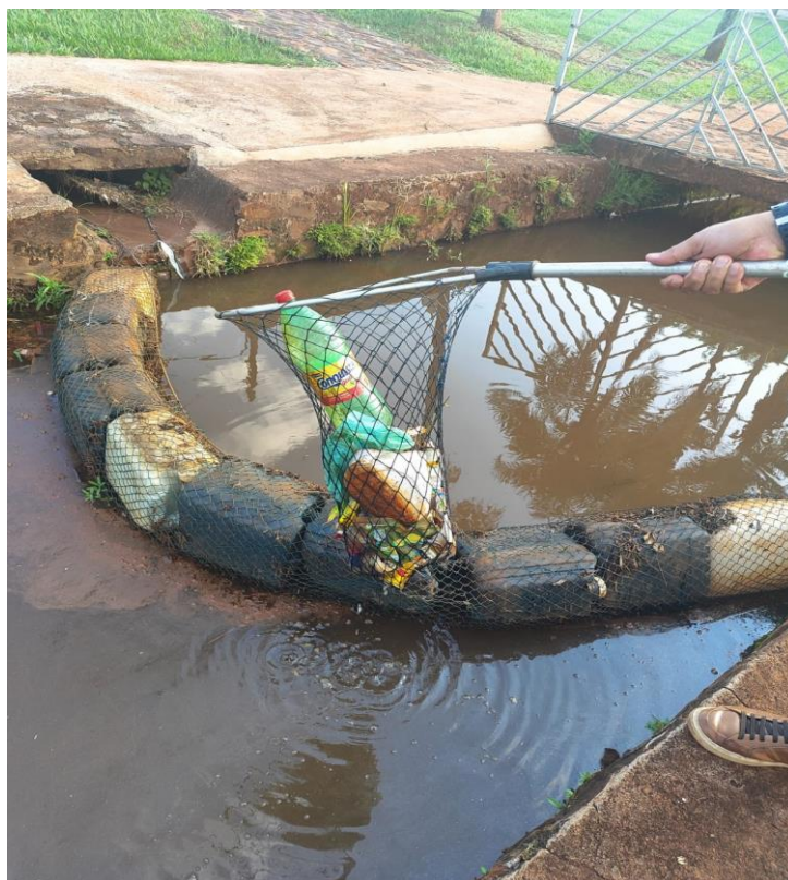
Figura 8. Direcionamento do resíduo flutuante para as margens e coleta com paçaguá na ecobarreira de Arandu – SP.
