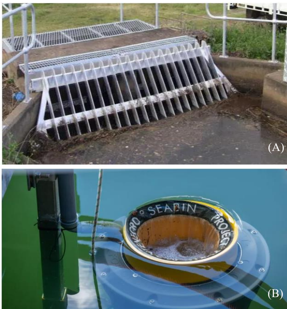
Figura 2. Tecnologias para retenção de resíduos: Trash Racks (A) e Seabin (B) implantadas em curso d'água
