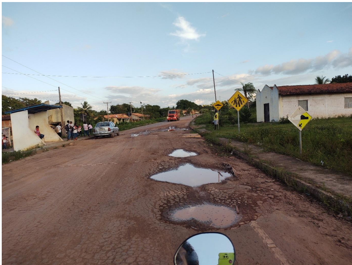
Imagem 25: Buracos no KM 24 da MA-211 perímetro da comunidade Ramal de Quindiuá dois anos após a inauguração
