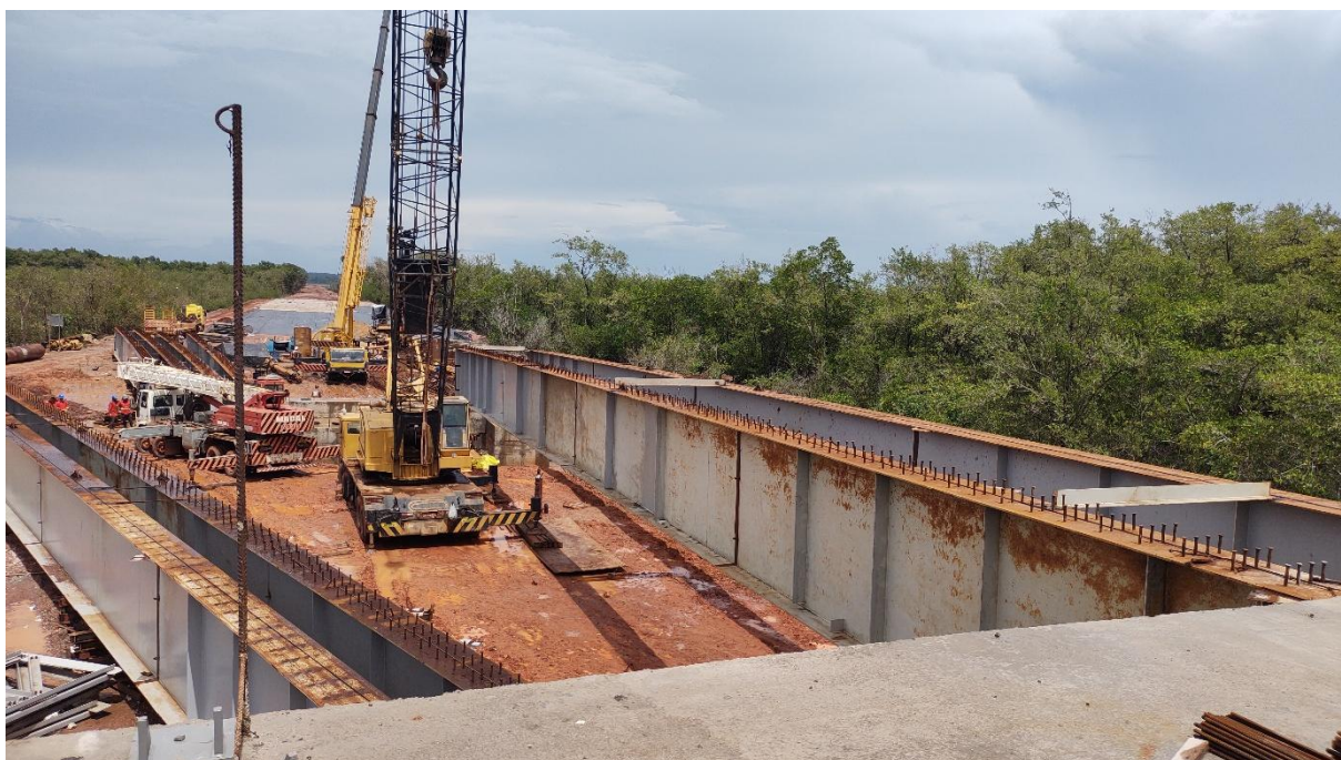
Imagem 21: Ponte Antônio Jorge Dino em fase de construção foto feita de cima da obra
