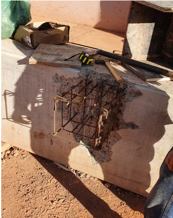
a) Armadura do consolo antes de sua concretagem
