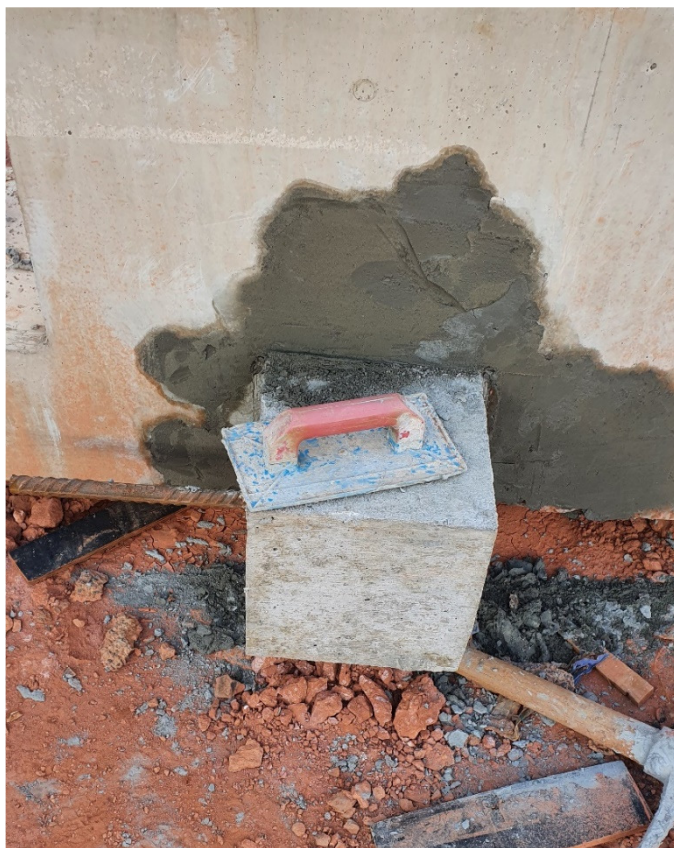
Figura 1.6 – Acabamento na superfície do pilar após a concretagem do consolo
