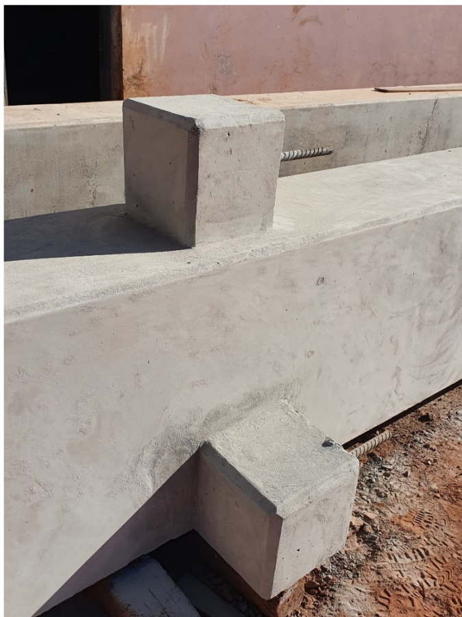
Figura 1.3 – Consolo de concreto
