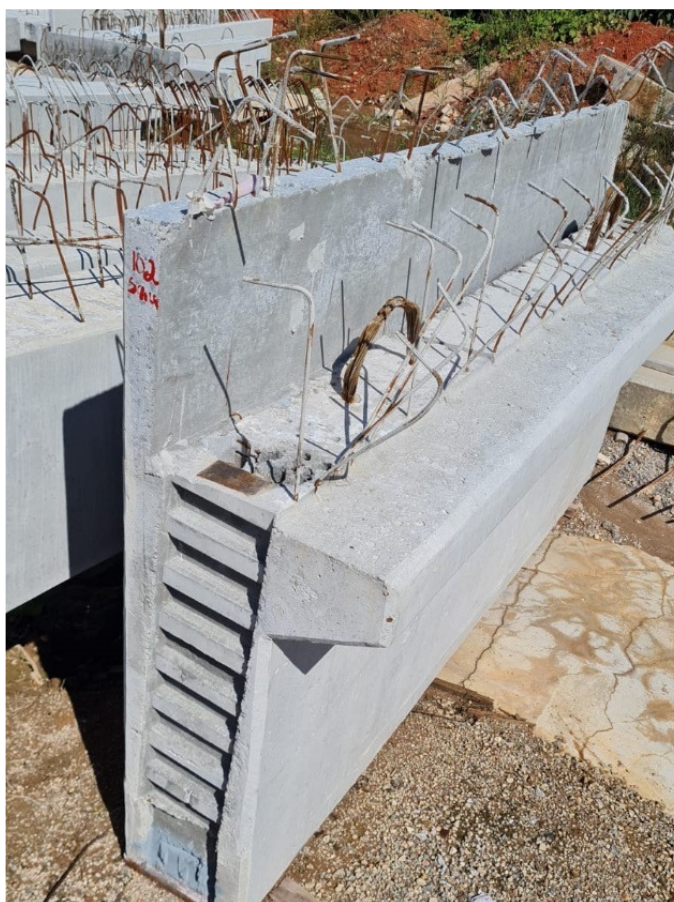
Figura 1.4 – Chave de cisalhamento viga-pilar
