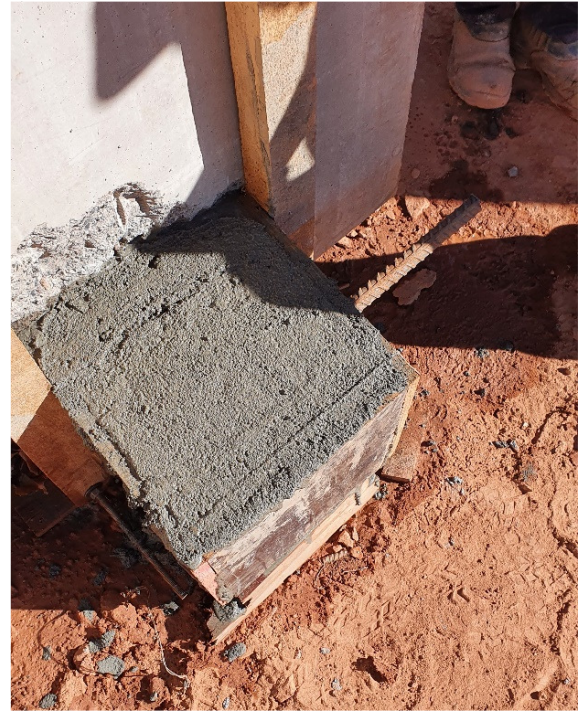
b) Consolo concretado dentro da fôrma de madeira
