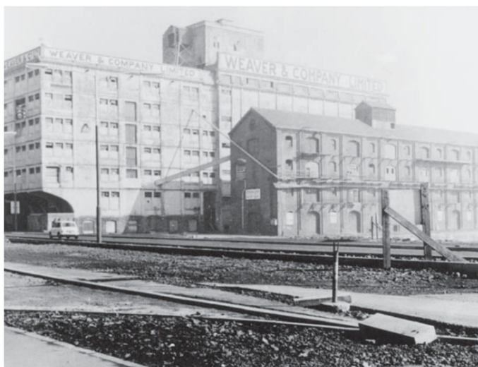
Figura 1.1 – Estrutura de Concreto Pré-moldado em Swansea, Reino Unido
