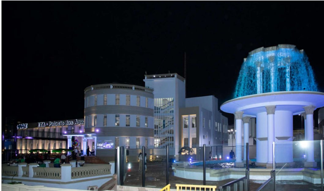
Figura 21 - ETA Palácio das Águas após o retrofit .
