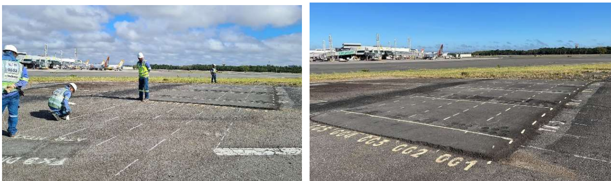
Figura 3.18 - Aspecto final da seção teste para estudo da fresagem: (a) marcação das linhas (b) layout final das áreas de fresagem. Fonte: Elaborado pelo autor (2024).
