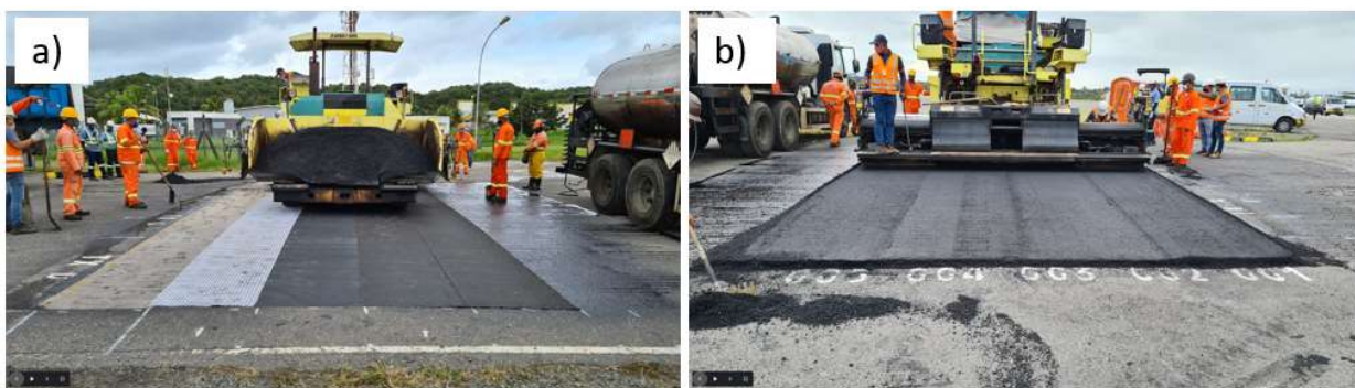
Figura 3.17 - Pista teste em processo de execução: a) Aplicação da mistura asfáltica; b) Compactação da mistura asfáltica. Fonte: Elaborado pelo autor (2024).
