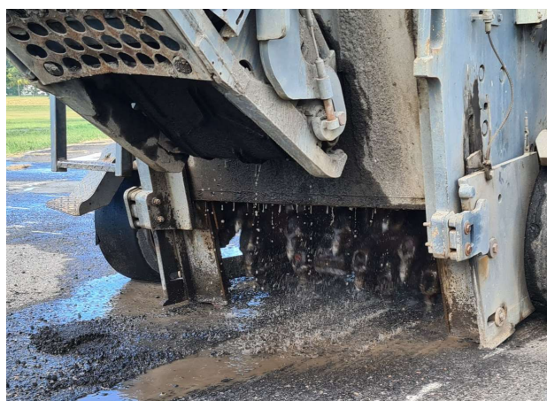
Figura 3.21 - Testes prévios para calibração do aspersor de água antes do processo de fresagem Fonte: Elaborado pelo autor (2024).
