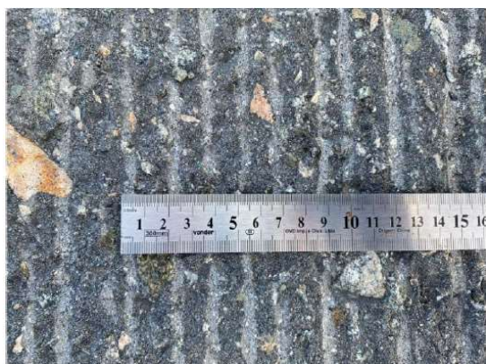
Figura 3.10 - Aspecto do pavimento após a fresagem. Fonte: Elaborado pelo autor (2024).
