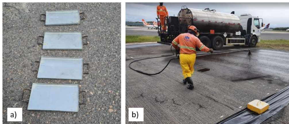
Figura 3.11 - Controle de taxa de emulsão: a) bandejas coletoras utilizadas no processo de aplicação da emulsão; b) bandejas coletoras de emulsão em utilização. Fonte: Elaborado pelo autor (2024)
