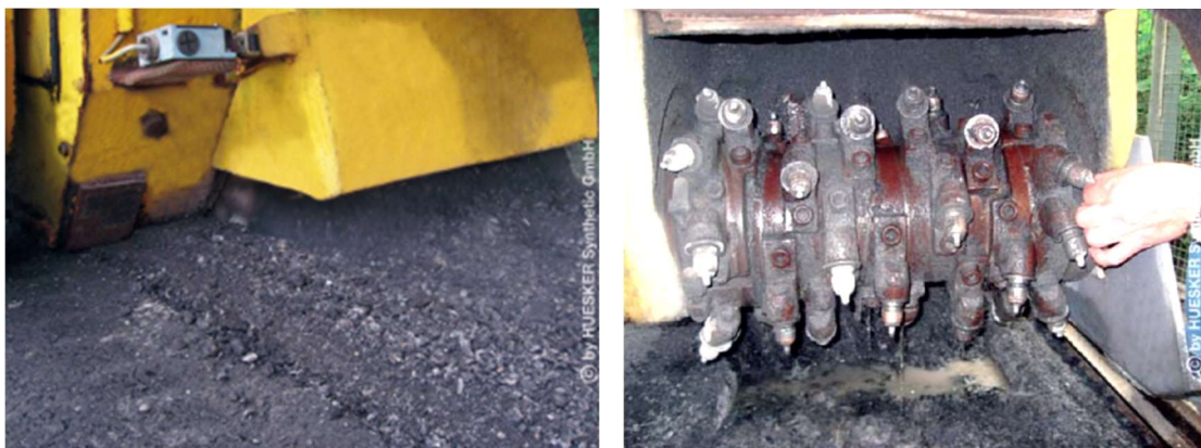
Figura 2.8 - Processo de fresagem: a) Fresagem da camada superficial incluindo o reforço; b) Detalhe do tambor de fresagem após o procedimento da fase 2. Fonte: Huesker (2008).
