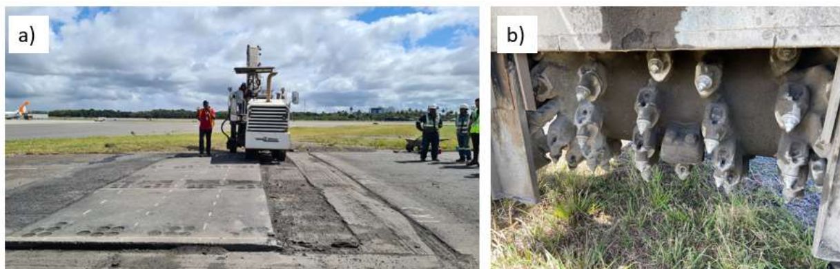
Figura 4.3 - Aspectos da fresagem da seção teste 2: a) seção teste após a fresagem e b) tambor de fresagem após, sem geossintético GG2. Fonte: Elaborado pelo autor (2024).
