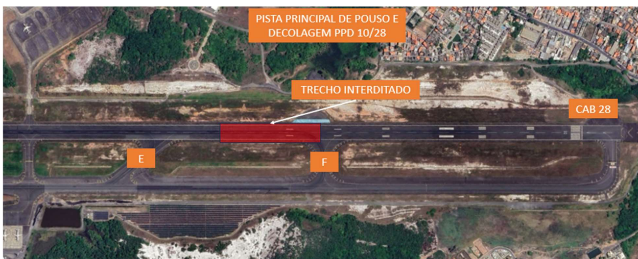
Figura 3.4 - Local deteriorado da PPD 10/28. Fonte: Elaborado pelo autor (2024).
