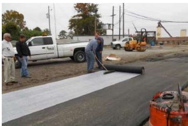
Figura 2.13 - Execução da pista teste. Fonte: Tran et al. (2012).
