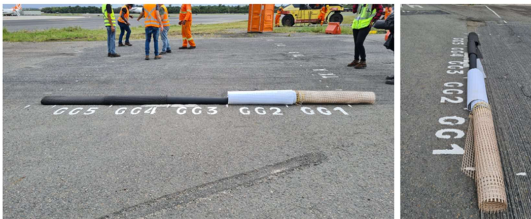
Figura 3.13 - Sinalização e alocação dos diferentes geossintéticos na seção teste. Fonte: Elaborado pelo autor (2024).
