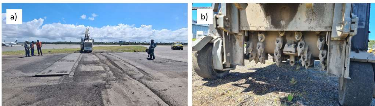
Figura 4.5 - Aspectos da fresagem da seção teste 4: a) seção teste após a fresagem e b) tambor de fresagem após, sem geossintético GG4. Fonte: Elaborado pelo autor (2024).
