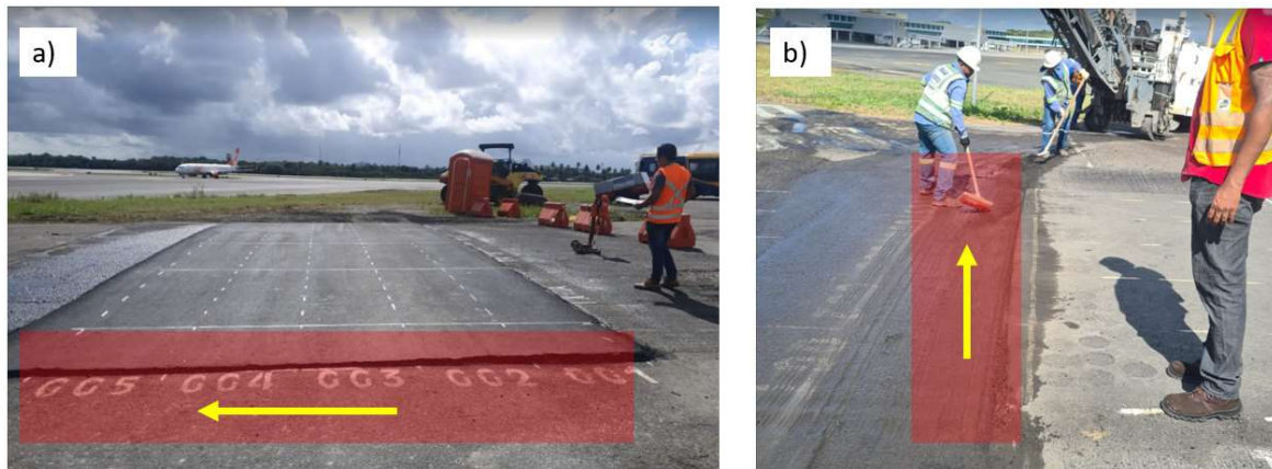
Figura 3.22 - Área teste de fresagem: a) área de pré-fresagem; b) fresagem após o teste Fonte: Elaborado pelo autor (2024).
