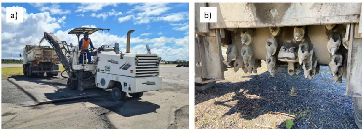
Figura 4.4 - Aspectos da fresagem da seção teste 3: a) seção teste após a fresagem e b) tambor de fresagem após, sem geossintético GG3. Fonte: Elaborado pelo autor (2024).
