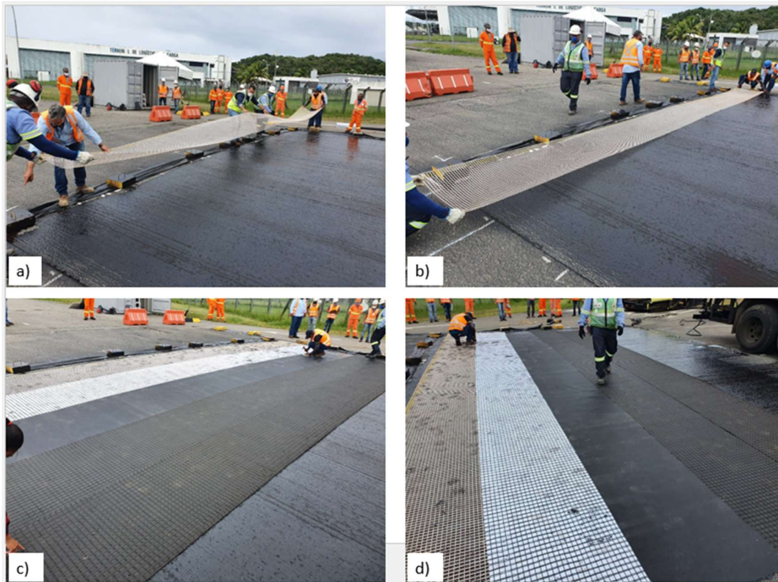
Figura 3.14 - Processo de instalação dos geossintéticos. a) Processo de instalação da GG1; b) finalização da instalação da GG1; c) Geossintéticos em processo de instalação; d) aspecto dos 5 diferentes geossintéticos após a instalação. Elaborado pelo autor (2024).
