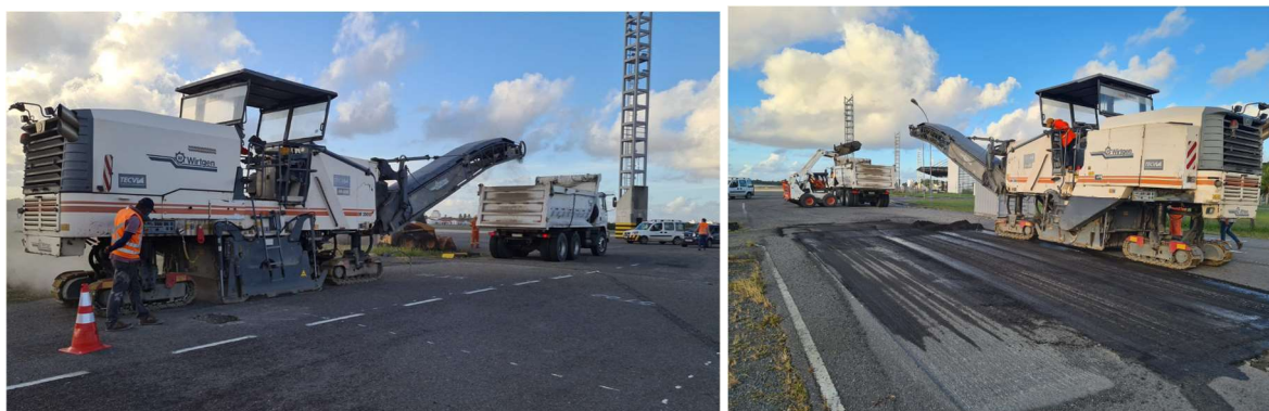
Figura 3.9 - Processo de fresagem da área da seção teste: com a utilização da Fresadora Wirtgen W200; Fonte: Elaborado pelo autor (2024).
