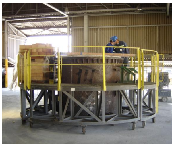
Figura 6.9 Detalhe externo do cadinho em manutenção
