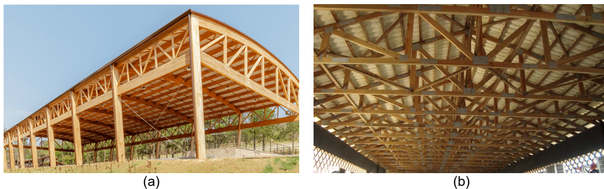
Figura 1.1 – Estruturas de cobertura industrializadas: (a) Treliça MLC; (b) Treliça CDE
