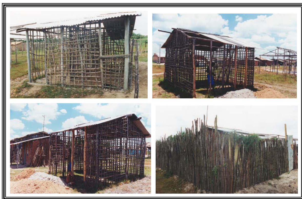
Figura 48 - Utilização de madeiras de mangue na construção civil em Acupe
