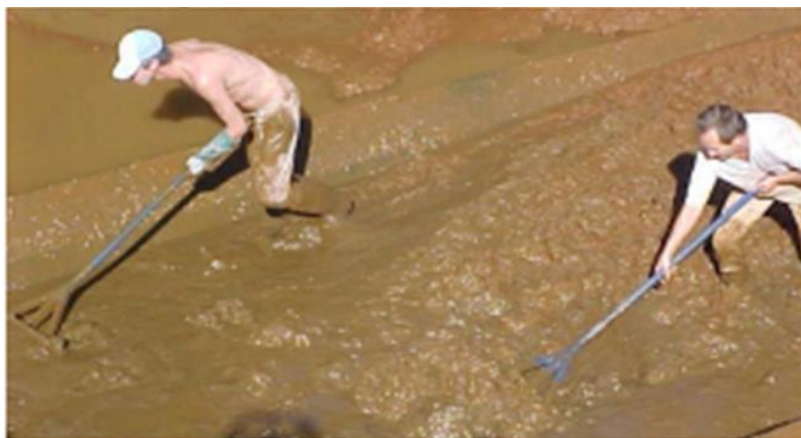
Figura 570 - Remoção de lodo dos decantadores de forma manual
