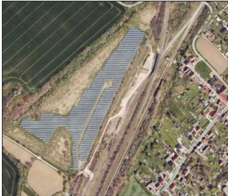
Figura 7- Foto aérea de usinas fotovoltaicas próximas a uma linha rodoviária.
