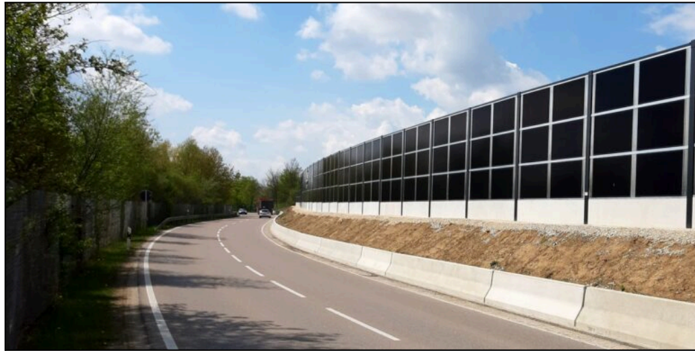
Figura 6- Placas de energia solar fotovoltaicas em estudo nas rodovias da Alemanha.
