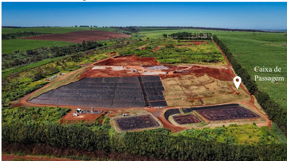
Figura 12 - Aterro Sanitário de São Carlos
