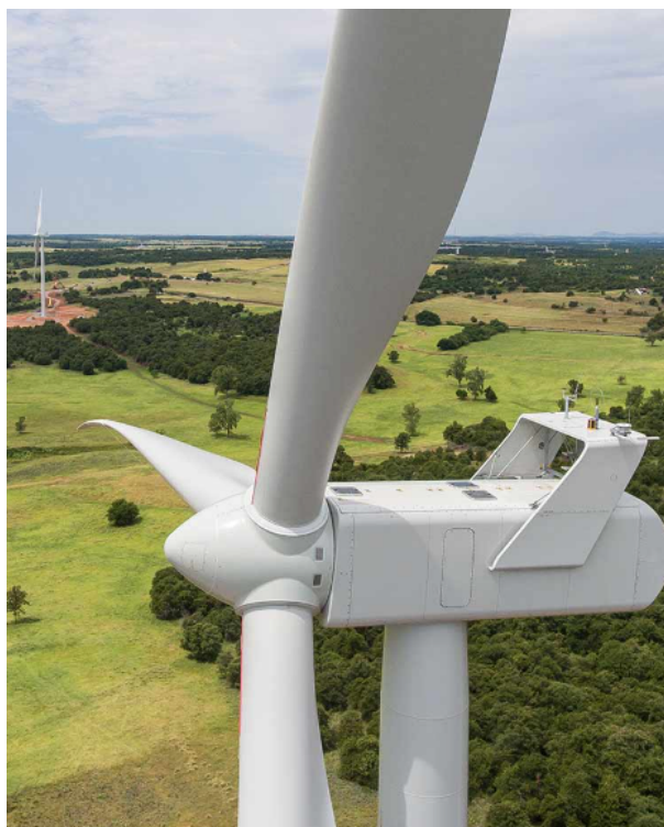
Figura 7 – Aerogerador de eixo horizontal com três pás
