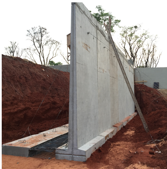
Figura 7: Construção de Muro de Arrimo em Concreto.
