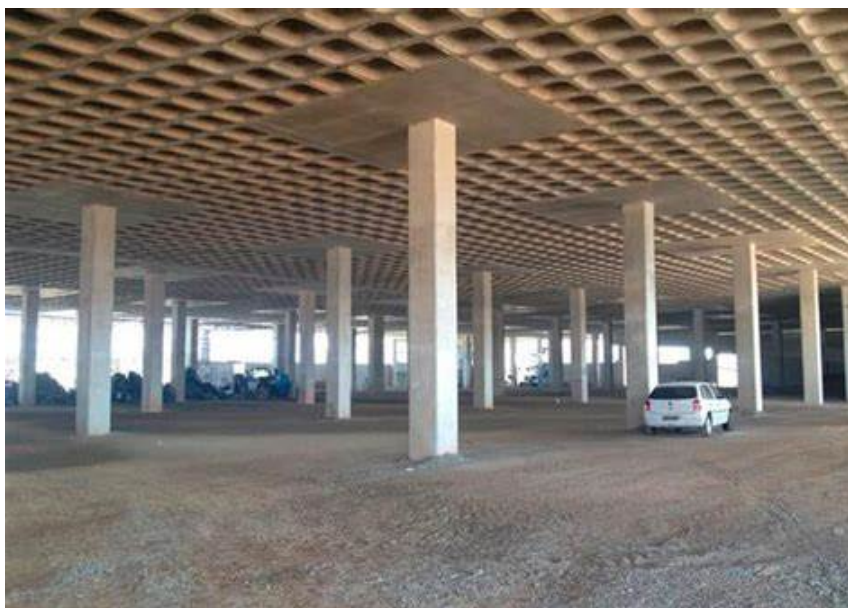
Figura 9: Detalhamento de Laje Nervurada.
