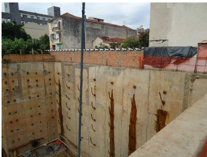
Figura 6: Projeto de Parede Diafragma para Estabilização Estrutural.
