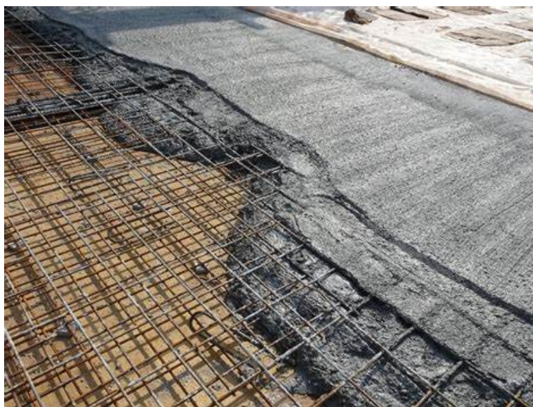
Figura 8: Laje Maciça de Concreto - Exemplo de Projeto.
