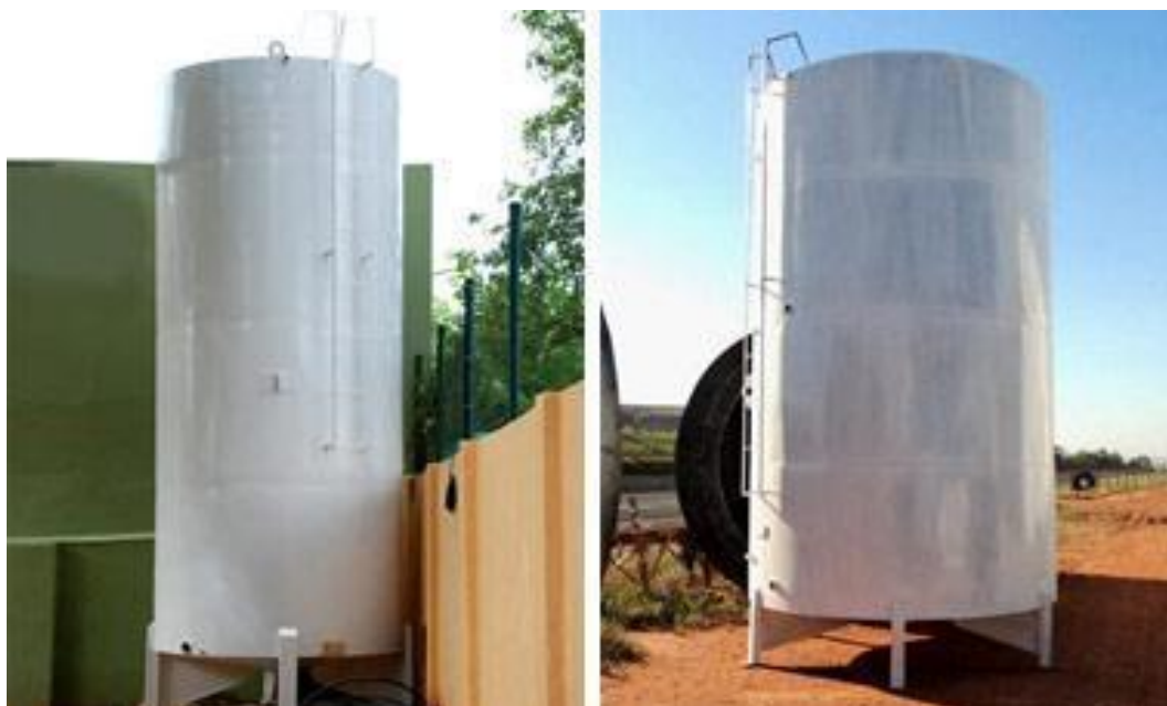
Figura 7 – Reservatórios de 30 mil litros
