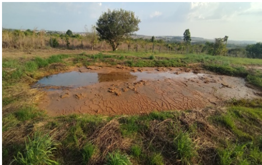
Figura 13– Lagoa de decantação do lodo e efluente dos filtros
