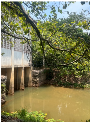
Figura 9 – Poço de sucção da captação de água no rio Uraim
