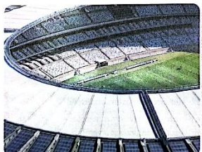
5.21 Estádio Governador Magalhães Pinto (conhecido como Estádio Mineirão), em Belo Horizonte (MG), 2013. Os módulos fotovoltaicos podem ser vistos na parte inferior da foto (em azul).
