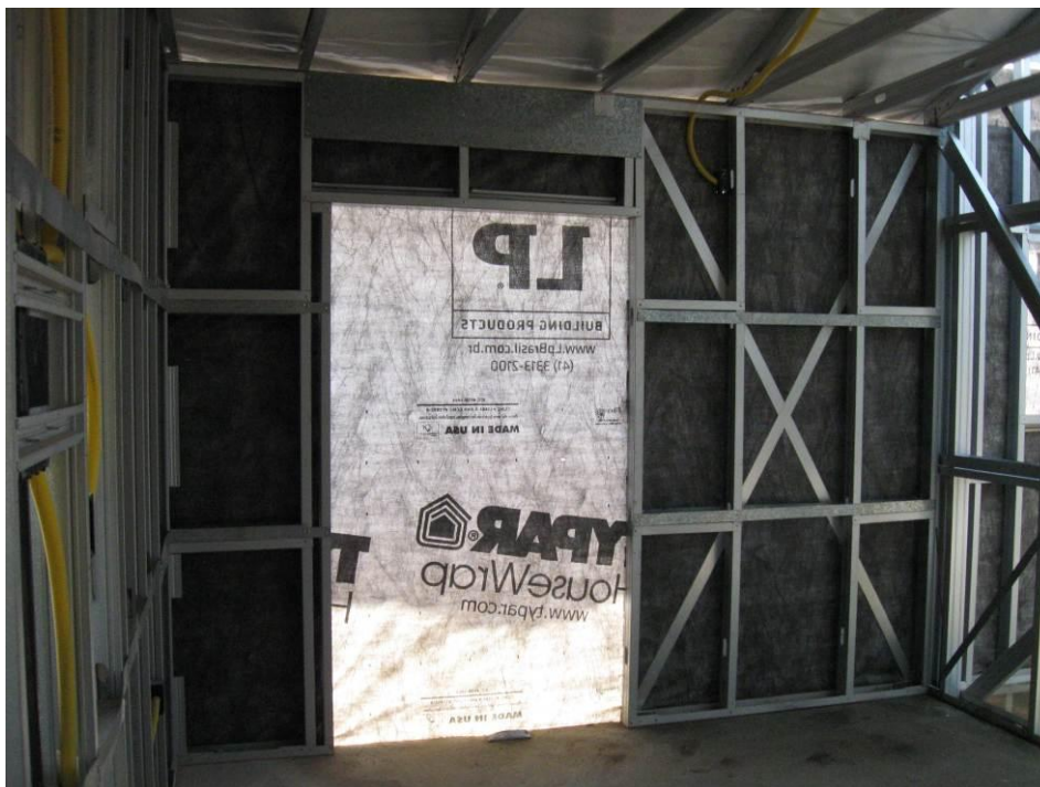
Figura 20 - Exemplo de painel estrutural
