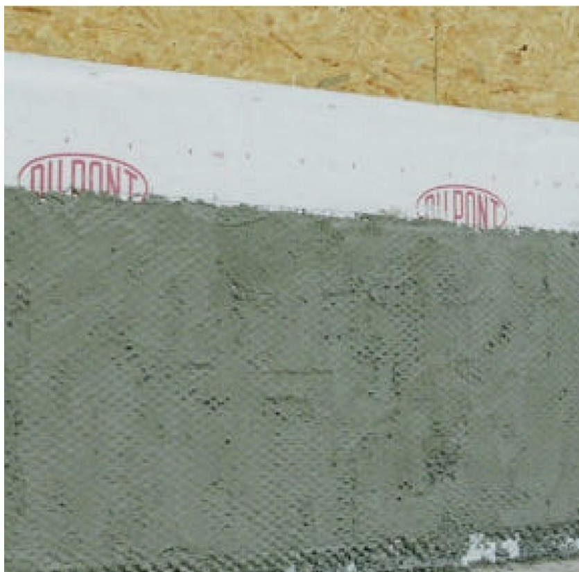
Figura 29 - Revestimento do OSB com tela e argamassa
