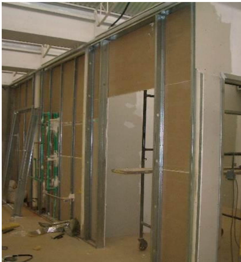
Figura 32 - Exemplo de fechamento em drywall
