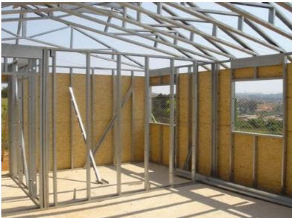
Figura 25 - Edificação em LSF com fechamento externo em OSB
