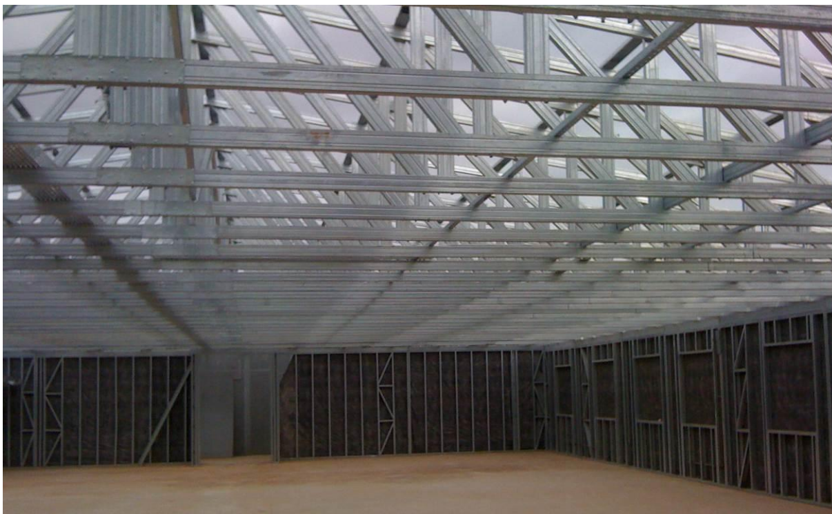
Figura 35 - Exemplo de estrutura de telhado com perfis
