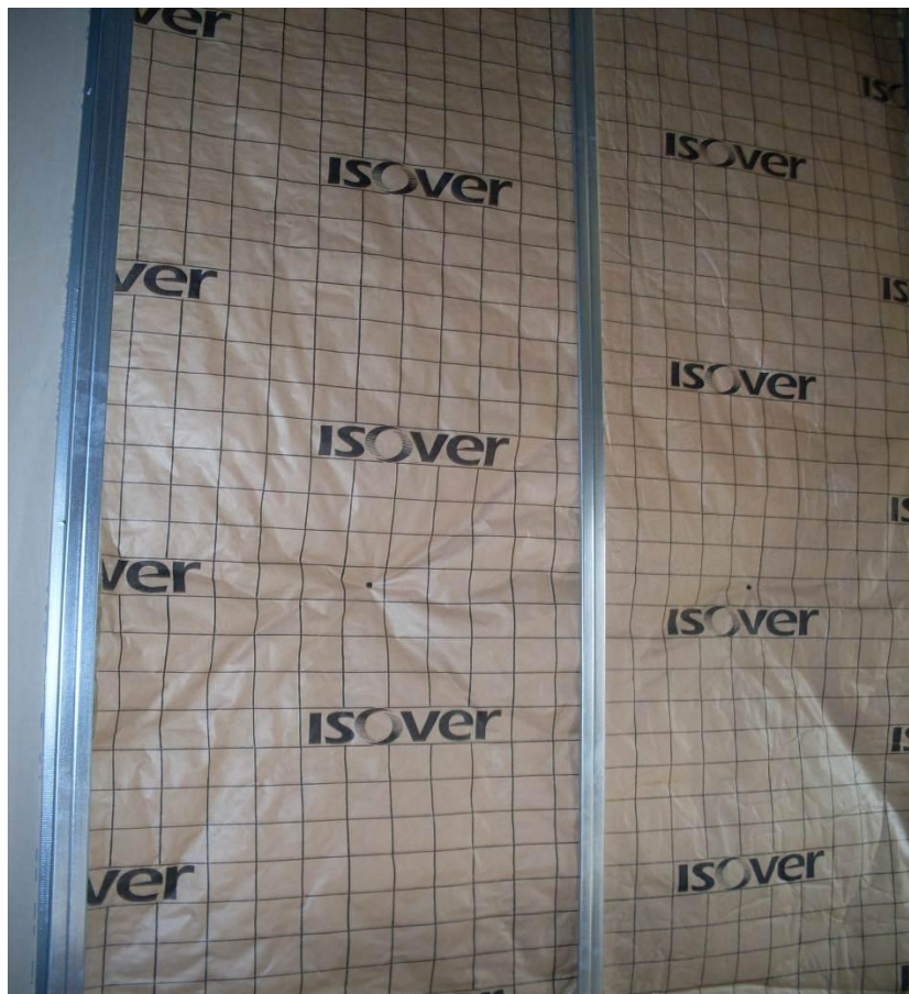
Figura 34 - Aplicação da manta de lã de vidro
