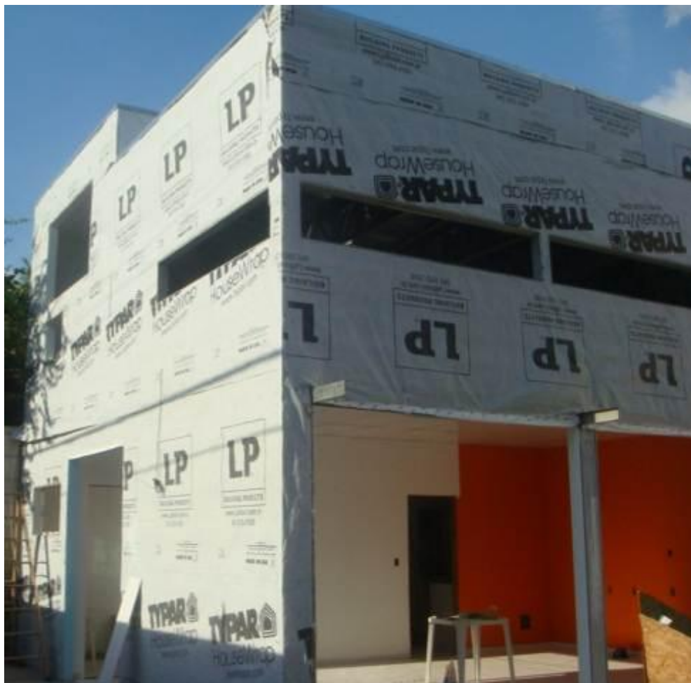
Figura 26 - Edificação em LSF com vedação em OSB e aplicação da membrana em polietileno de alta densidade.
