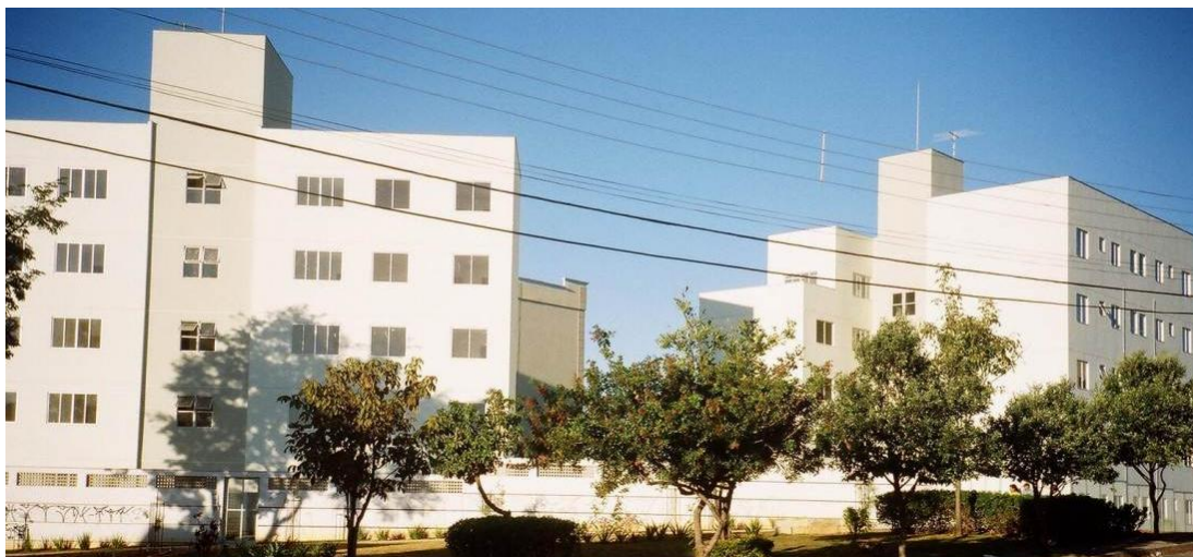
Figura 13 - Exemplo de edificação em LSF.
