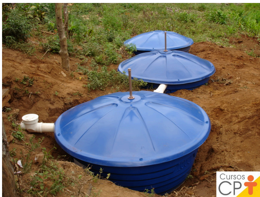
Figura 9 - Estrutura da Fossa Séptica Biodigestora
