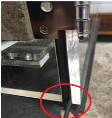
Figura 66 - Abertura na lateral da porta.
