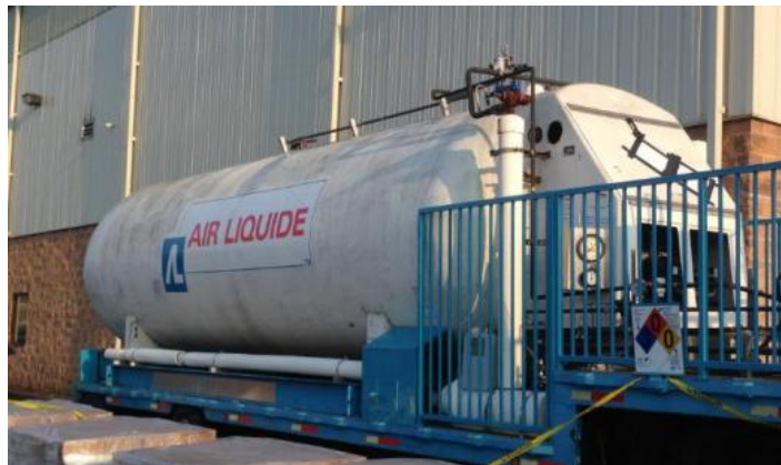
Figura 81 - Tanque para armazenamento de CO 2 capturado.
