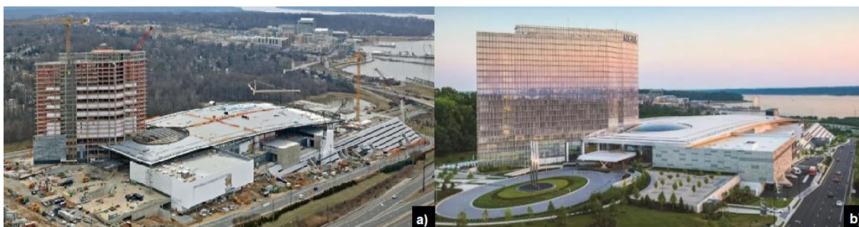
Figura 1 - Resort MGM National Harbor, construído com blocos curados com \text{CO}_2 : a) durante a construção, b) após a construção.
