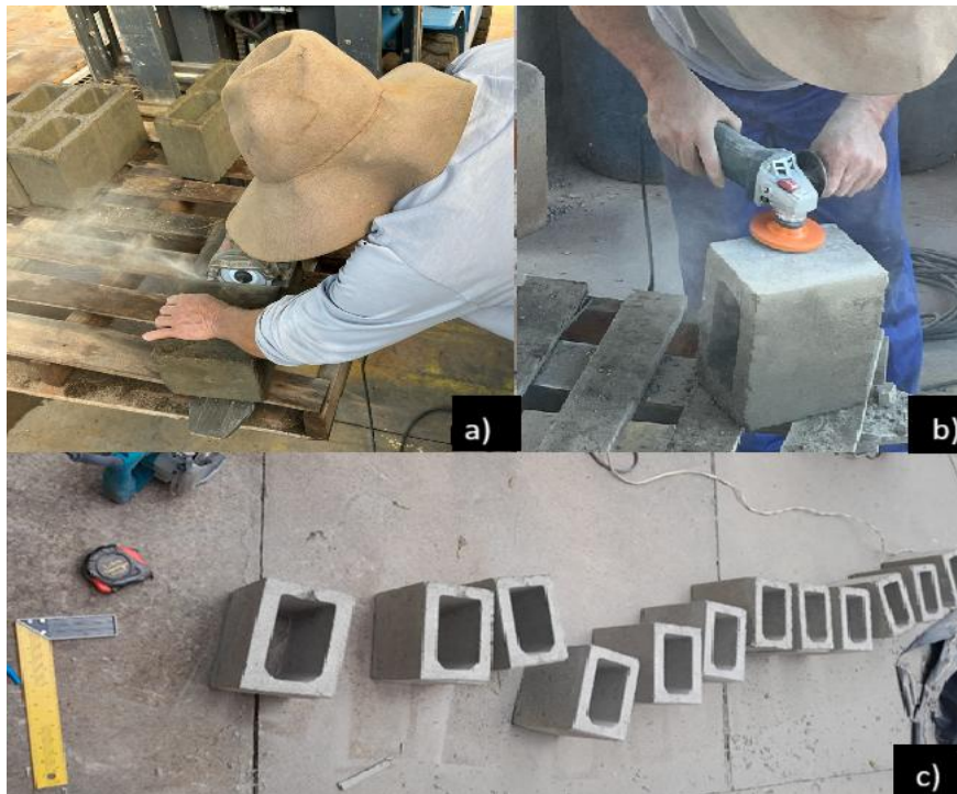
Figura 129 - Preparo dos meios blocos: a) Corte dos blocos com makita, b) Desbaste com lixadeira, c) Regularização final com utilização de makita e esquadro.
