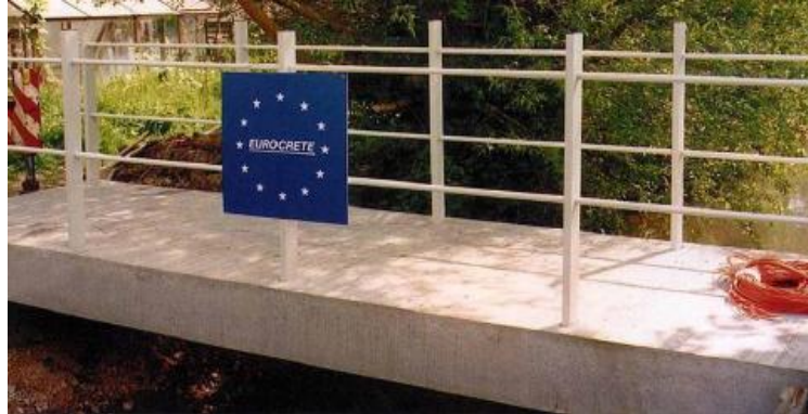
Figura 2: Primeira passarela de concreto da Europa com armadura de FRP
