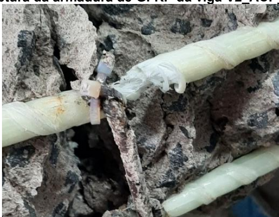
Figura 93: Ruptura da armadura de GFRP da viga V2_ACP_GFRP_10000h
