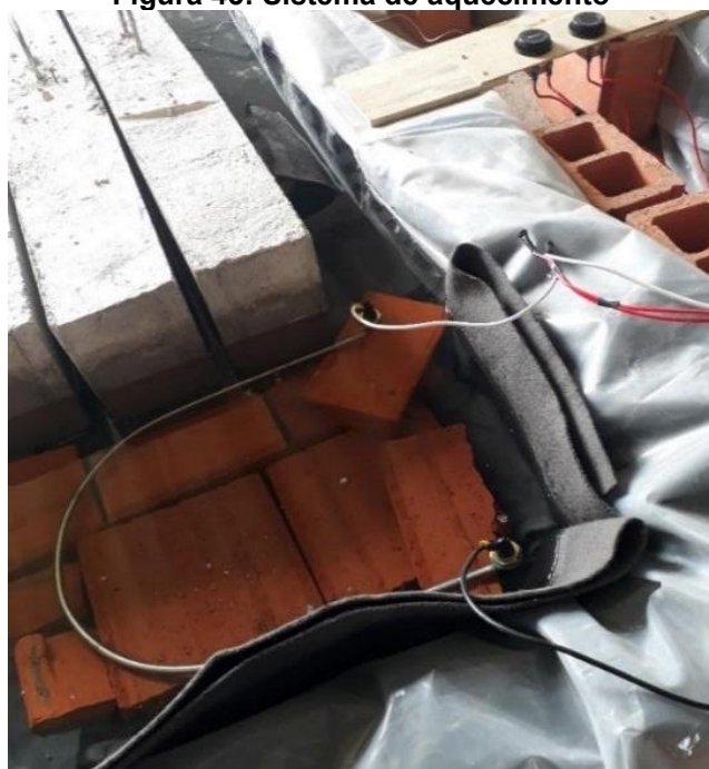
Figura 43: Sistema de aquecimento
