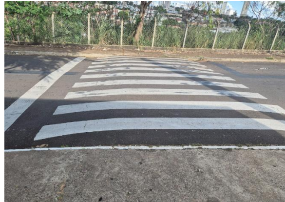
(b) Faixa Elevada 1 - Lateral
