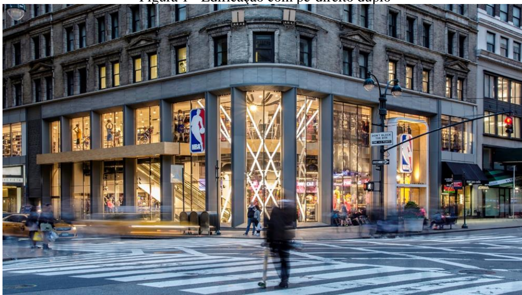
Figura 1 - Edificação com pé-direito duplo
