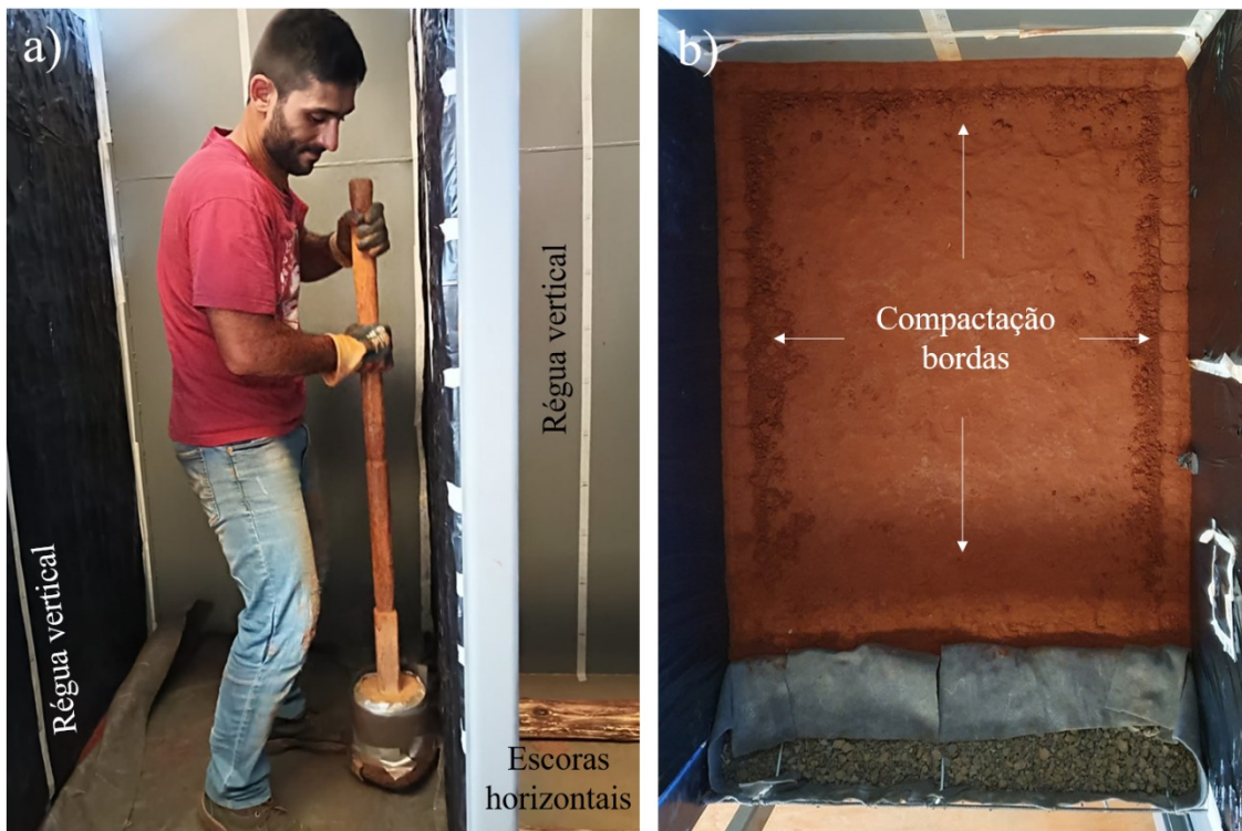
Figura 3.9: a) Camada experimental; b) Compactação bordas.
