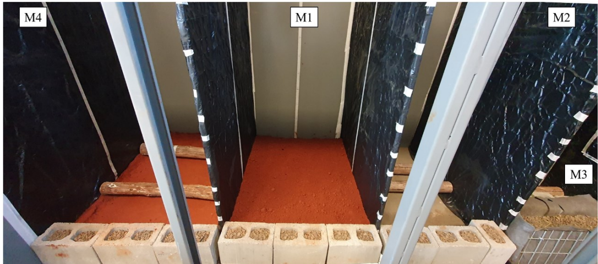
Figura 3.10: Camada experimental finalizada (M4_0.3m_SD_B) e solo espalhado para a compactação da camada experimental (M1_0.6m_SD_B).
