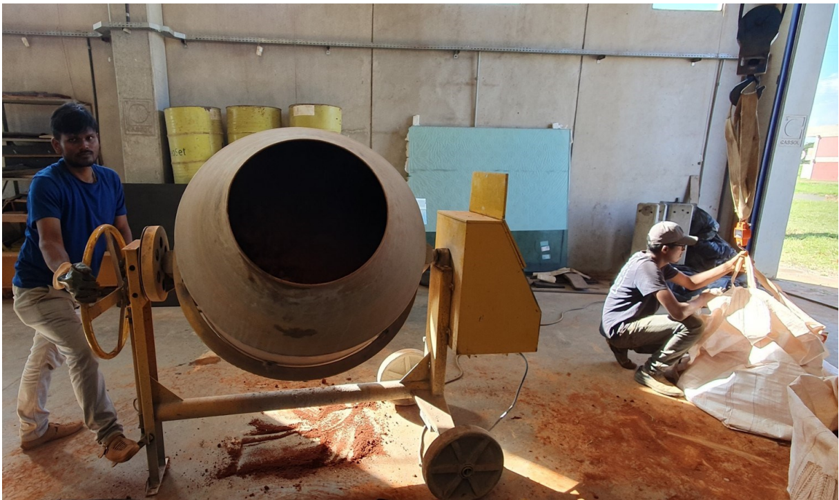
Figura 3.8: Pesagem solo seco e homogeneização do material para a correção do teor de umidade.
