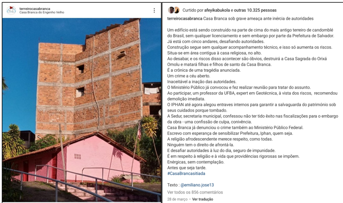
Figura 9 – Imagens sobre o movimento de solicitação para embargar a obra com risco de desabamento.
