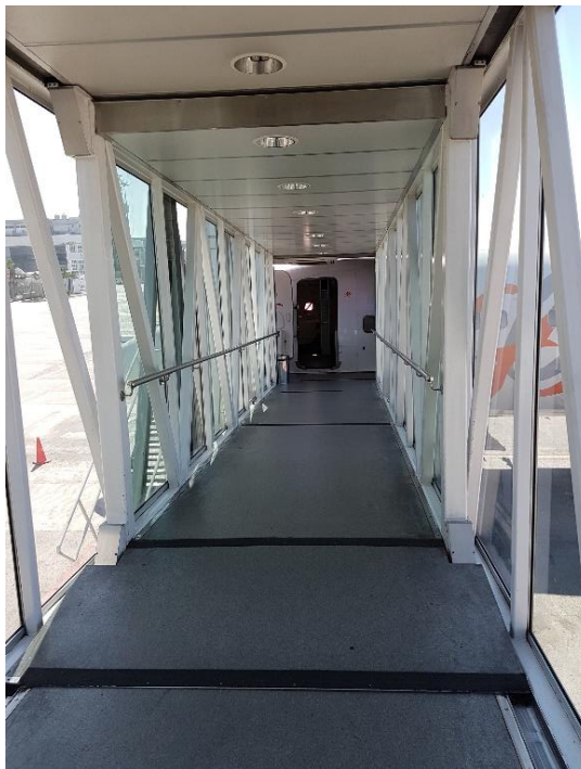
Figura 4.10 Finger conectando o terminal à porta da aeronave.
