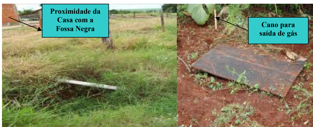
Figura 21. Exemplo de esgotamento sanitário/fossa negra.
