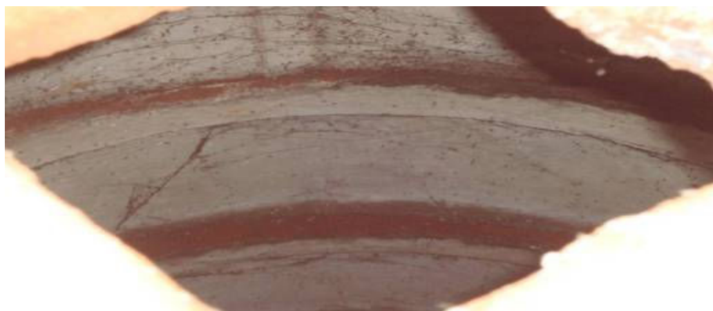
Figura 19. Revestimento interno da fossa feito de alvenaria.
