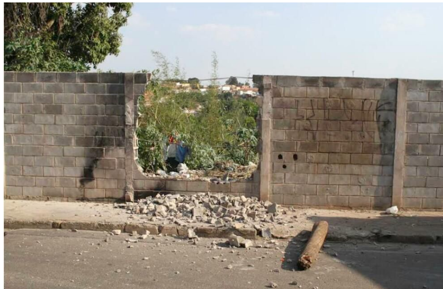
Imagem 4 - A derrubada do muro.
