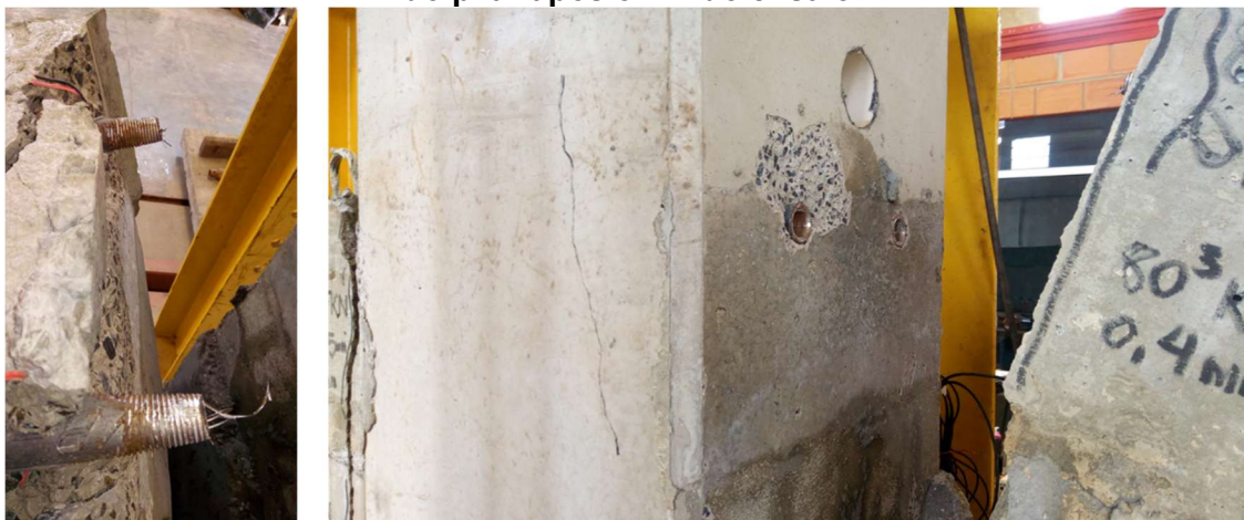
Figura 4.22: Configuração da rosca e do concreto ao redor da luva na interface do pilar após o fim do ensaio
