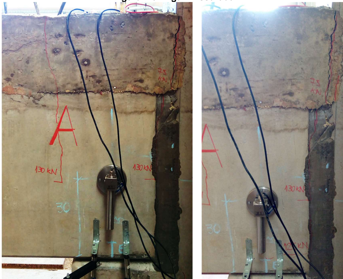
Figura 4.6: Viga A fissurada
