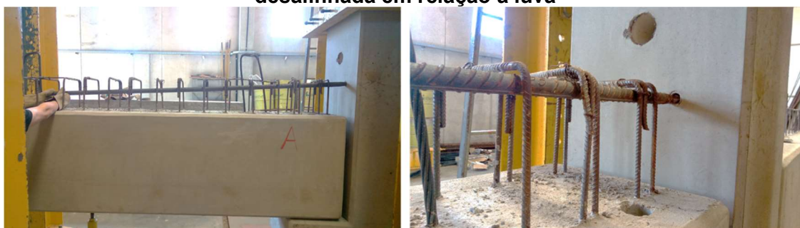
Figura C.2: Posicionamento da armadura negativa na viga A. Armadura pouco desalinhada em relação à luva
