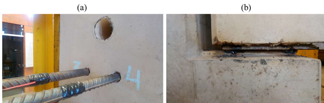
Figura C.10: (a) Armaduras negativas rosqueadas com strain gages já colados (b) Chapas metálicas da viga e consolo soldadas
