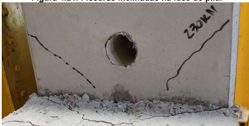
Figura 4.21: Fissuras inclinadas na face do pilar
