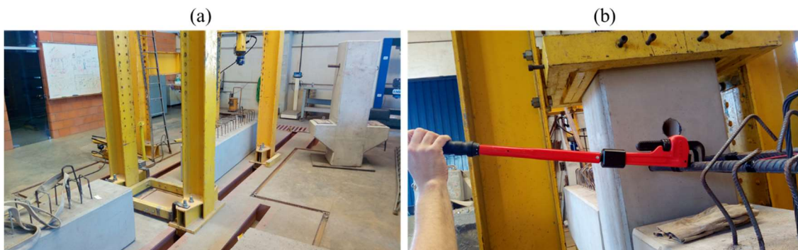
Figura C.8: (a) Posicionamento das peças de concreto pré-moldado (b) Rosqueamento das armaduras negativas com uso de torquímetro do fabricante Lenton®
