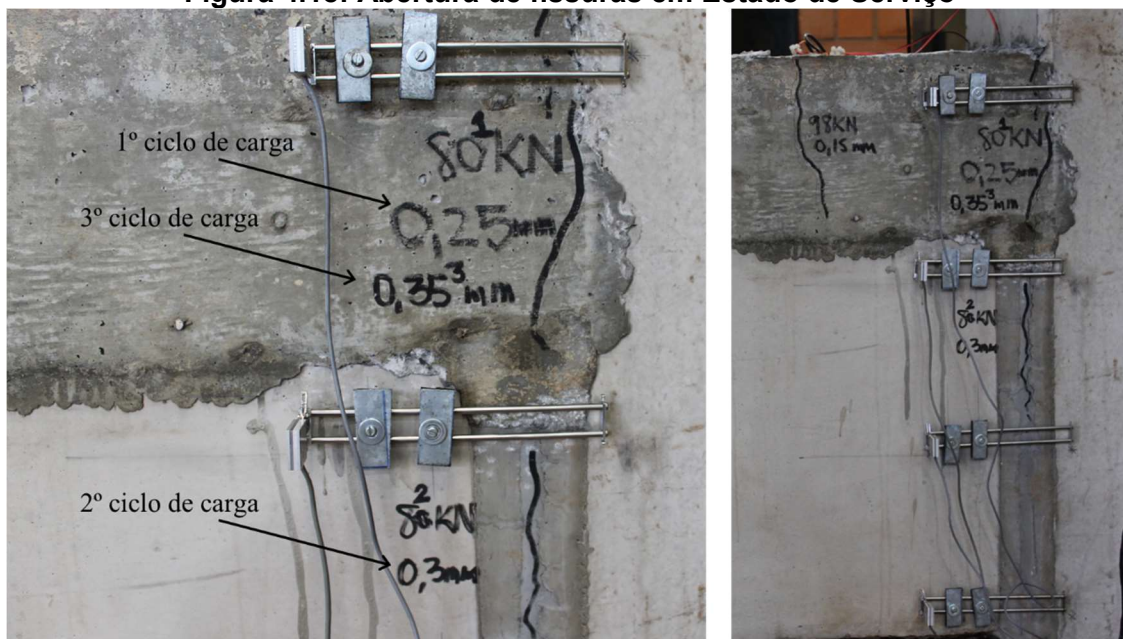
Figura 4.18: Abertura de fissuras em Estado de Serviço
