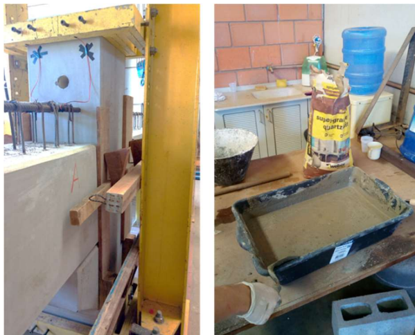
Figura 3.24: Preparação para o grauteamento das juntas verticais e nichos dos chumbadores
