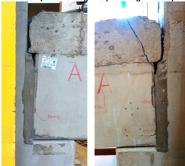
Figura 4.9: Faces opostas da viga A após a segunda etapa de ensaio
