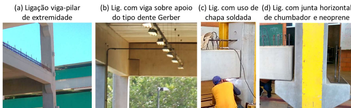
Figura 1.2: Diferentes tipos de ligações viga-pilar
