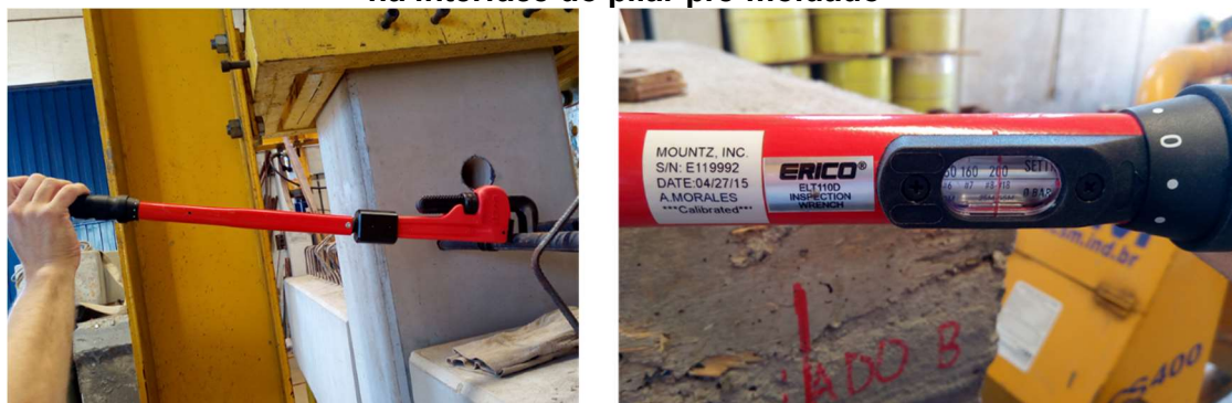
Figura 4.17: Torquímetro utilizado para rosquear as barras nas luvas em espera na interface do pilar pré-moldado
