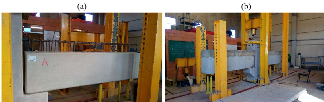
Figura C.6: (a) Viga A preparada para concretagem (b) Modelo pronto após a concretagem de segunda etapa
