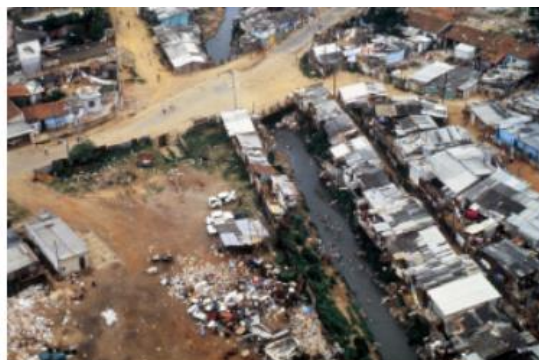
Figura 25 - Favela às margens do córrego Água Espreada
