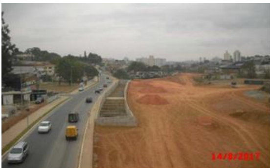
Figura 38 - Canalização do córrego Água Espreada
