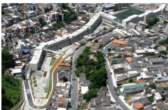
Figura 4 - Obra de urbanização de favelas do PAC em São Paulo - SP
