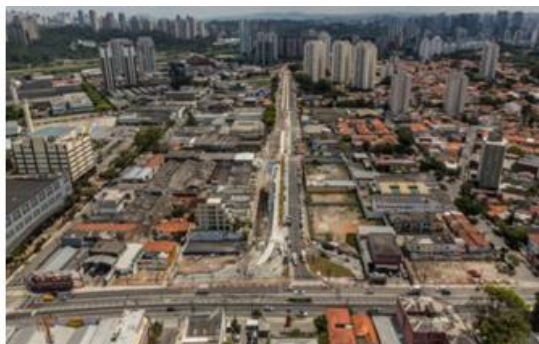
Figura 39 - Prolongamento Avenida Chucrí Zaidan
