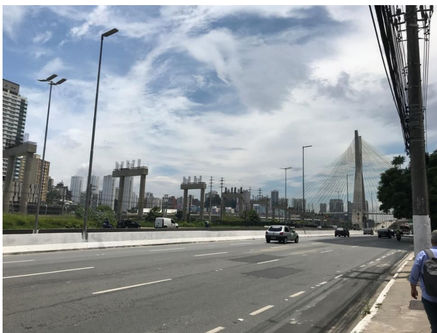
Figura 28 - Ponte Estaiada vista da Marginal Pinheiro, com as obras inacabadas do monotrilho ao fundo.
