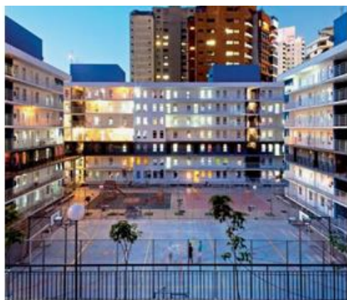
Figura 18 - Conjunto Habitacional Real Parque
