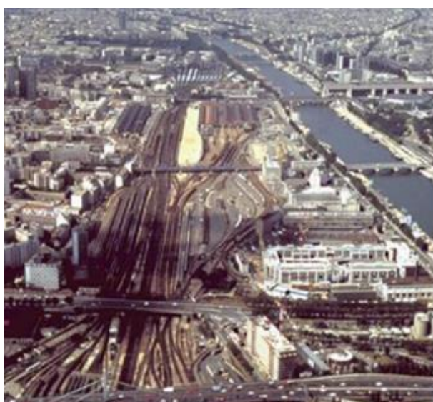
Figura 6 - Área da ZAC Paris Rive Gauche no início das obras
