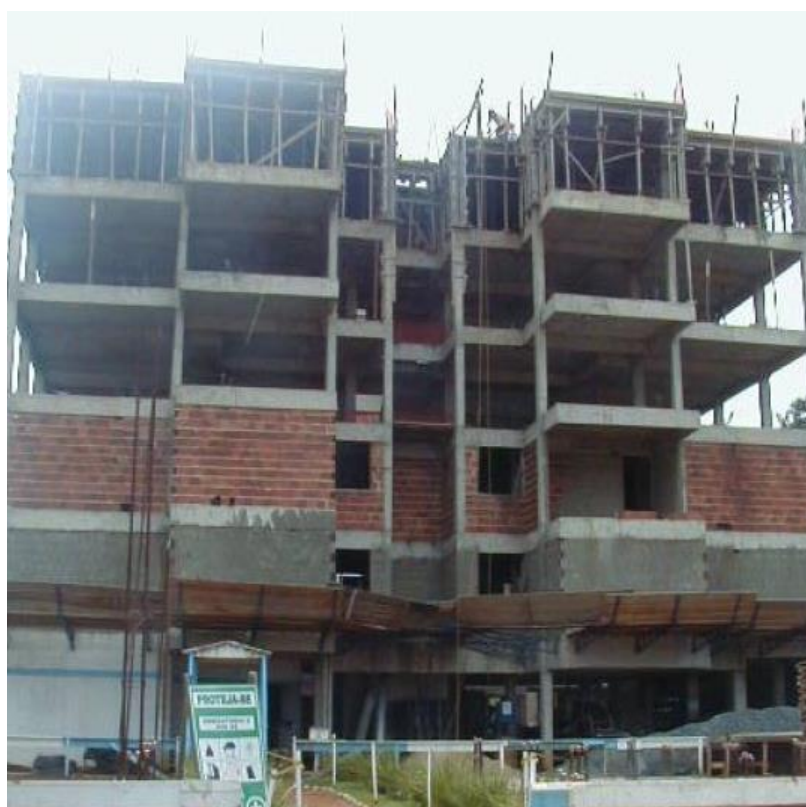
Figura 4.1 - Vista do edifício Camila
