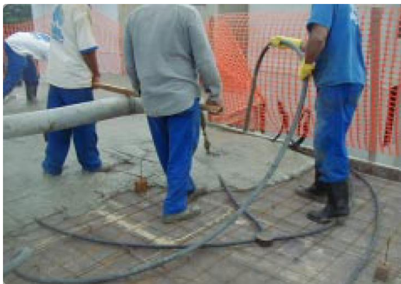
Figura 4.2 - Lançamento do CAA na laje
