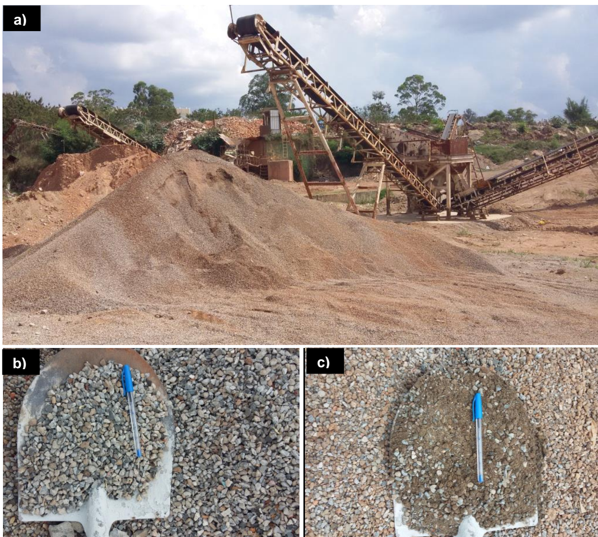
Figura 5.2 – Lote para coleta dos agregados graúdos reciclados (a), face exterior da pilha (b), material abaixo da camada de 30 cm
