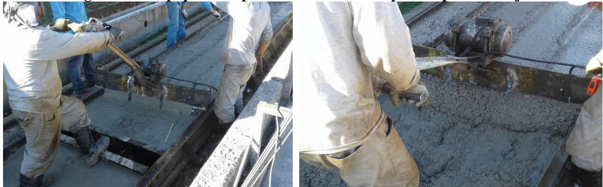
Figura 5-38: Equipamento para dar acabamento a parte superior da laje
