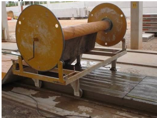
Figura 5-48: Cura com lona térmica
