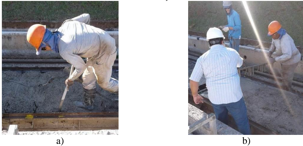
Figura 5-37: a) adensamento do concreto nas nervuras e da borda superior da laje b) remoção das “barras” de fixação do EPS
