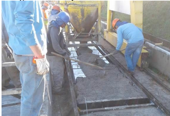
Figura 5-36: Espalhamento do concreto
