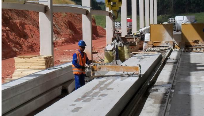
Figura 5-53: Posicionamento do balancim para a movimentação da laje alveolar
