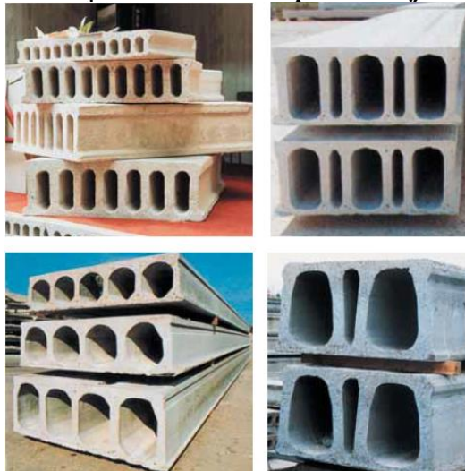
Figura 2-3: Seções transversais típicas de lajes alveolares
