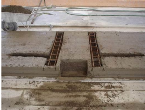
Figura 5-43: Posicionamento da armadura de reforço em laje alveolar
