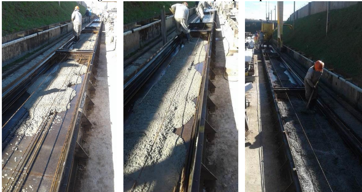
Figura 5-27: Concreto sendo lançado por etapas
