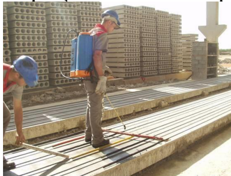
Figura 5-14: Aplicação de desmoldante com pulverizador
