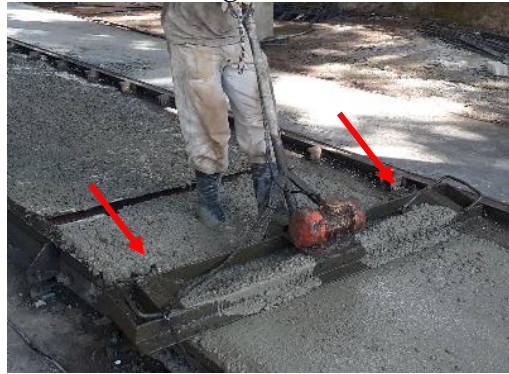
Figura 7-36: Interferência da régua vibratória com a alça de içamento
