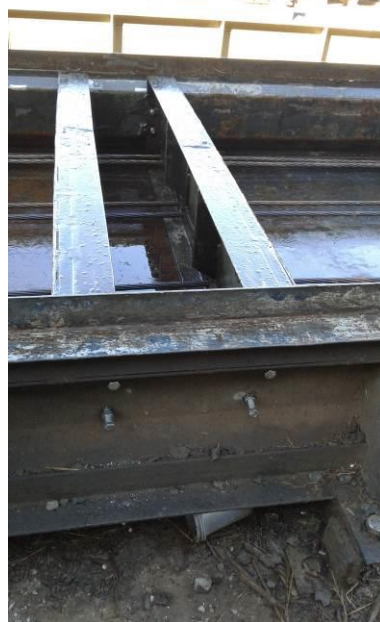
Figura 5-12: Fixação das tampas extremas nas fôrmas laterais
