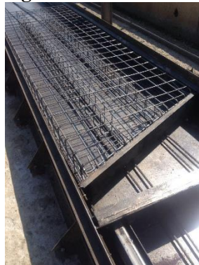
Figura 5-46: Laje alveolar moldada por fôrma fixa, com posicionamento de armadura antes da concretagem e extremidade em chanfro
