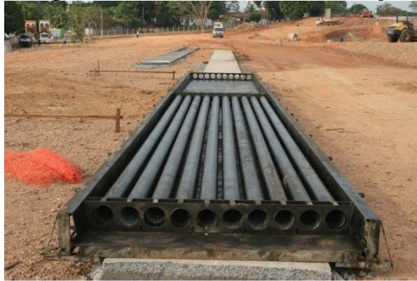
Figura 5-6: Fôrma contendo tubos de aço
