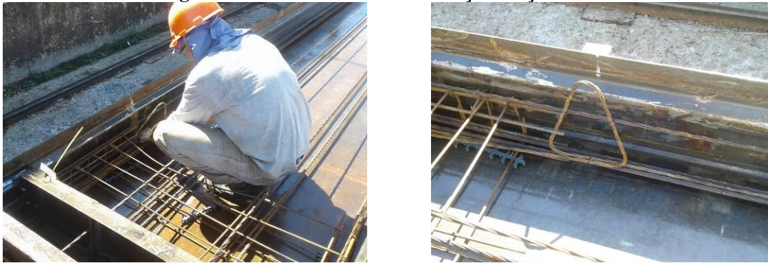
Figura 5-55: Posicionamento das alças de içamento
