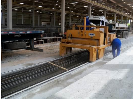
Figura 5-16: Aplicação de desmoldante por meio de equipamento
