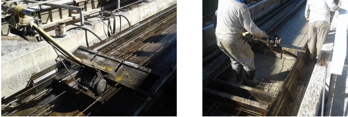
Figura 5-28: Equipamento desenvolvido para vibração e regularização de camada de concreto
