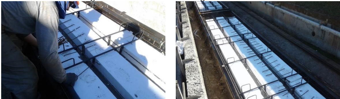
Figura 5-34: Posicionamento do gancho em “U”
