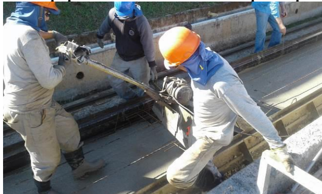
Figura 5-29: Equipamento sendo transferido para a próxima laje
