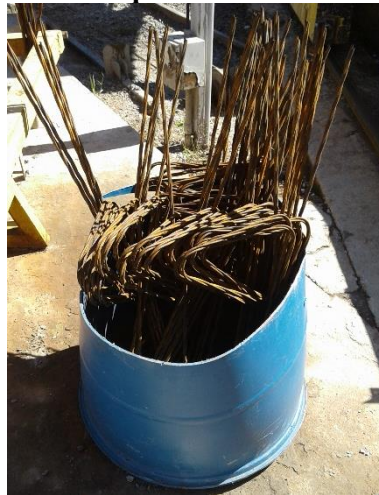
Figura 5-54: Cordoalhas dobradas para serem utilizadas como alças de içamento
