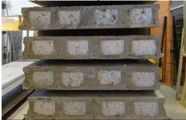
Figura 2-20: Laje alveolar moldada por fôrma fixa, e utilização de EPS
