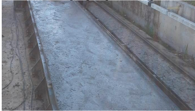
Figura 5-49: Método de cura simples para posterior saque e movimentação da laje
