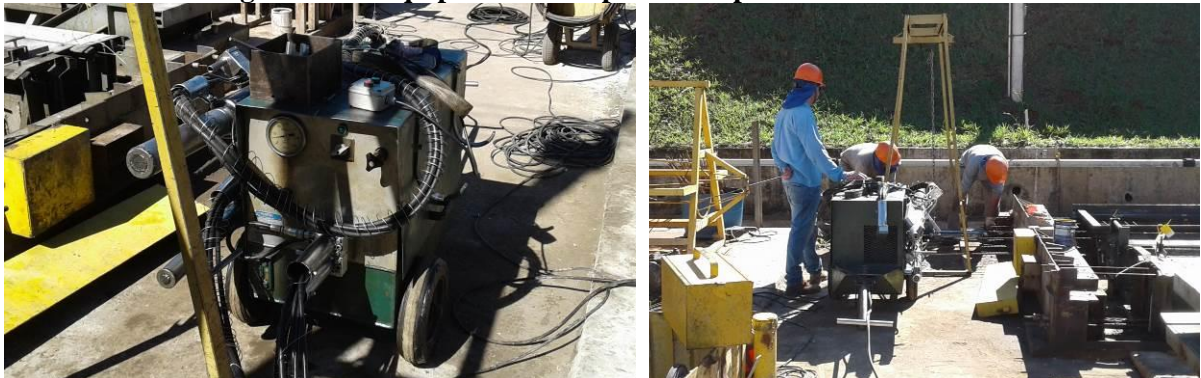
Figura 5-22: Equipamentos de protensão para cabos isolados
