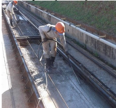
Figura 5-24: Concreto vibrado na produção da laje alveolar moldada por fôrma fixa
