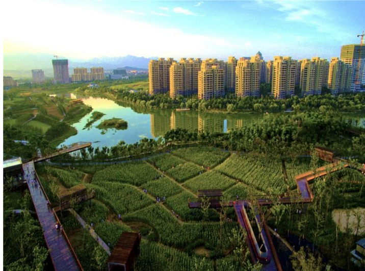
Figura 18 – Vista Quzhou Luming Park, província de Zhejiang, China. Fonte: Turenscape, 2015
