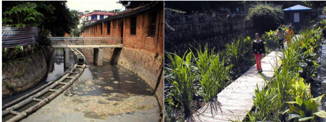
Figura 16 – Vista do Canal Baina, Fuzhuo, China antes e depois da revitalização com a implantação de wetlands.
