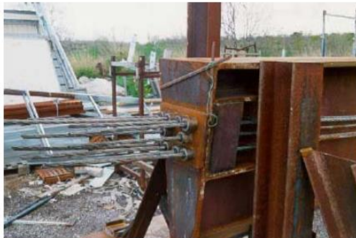
Figura 3.14: Viga metálica com enrijecedores
