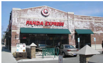
Figura 4 – Edifício com extrema eflorescência
