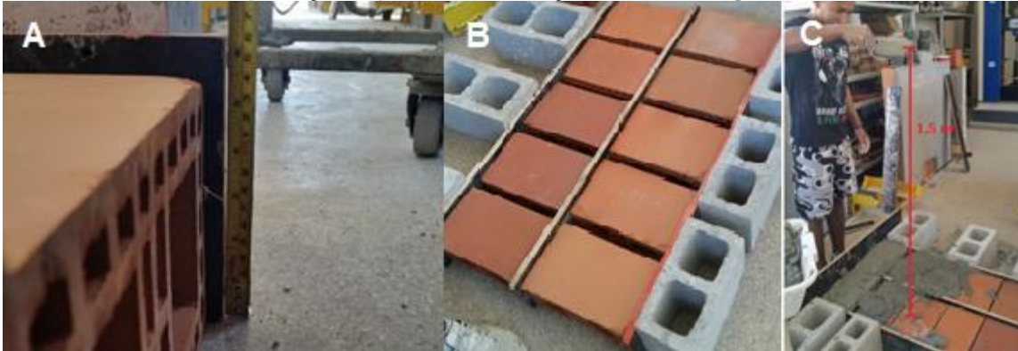
Figura 43- A) Gabarito par verificar a espessura do revestimento B) Layout da aplicação C) Altura de lançamento da argamassa
